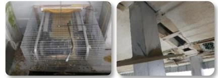
集卵コンベアなどの開口部の隙間を塞ぐ。普段目の届きにくい屋根裏や入気口も点検し、破損があれば補修。
