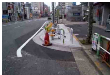
歩道の一部を活用した駐輪場整備 (東京都豊島区)
