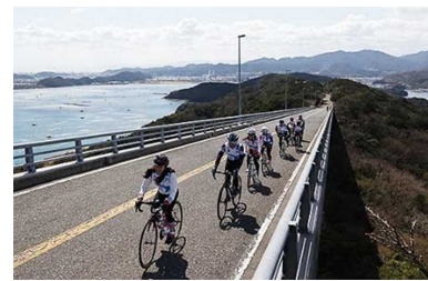
鳴門スカイライン（四方見橋）
