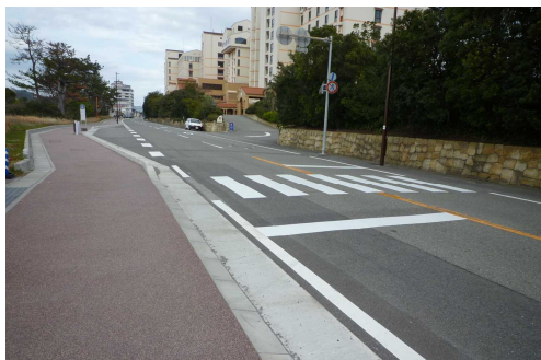
自転車歩行者道の整備 (県道 鳴門公園線 鳴門市鳴門町土佐泊浦)
