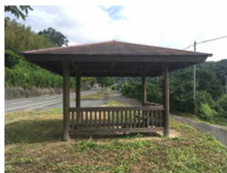
遍路小屋（板野郡板野町）
