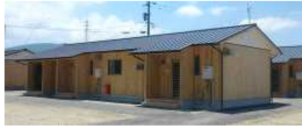
木造応急仮設住宅
