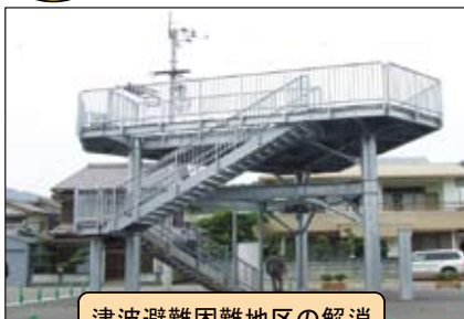
津波避難困難地区の解消 津波避難タワーの整備
