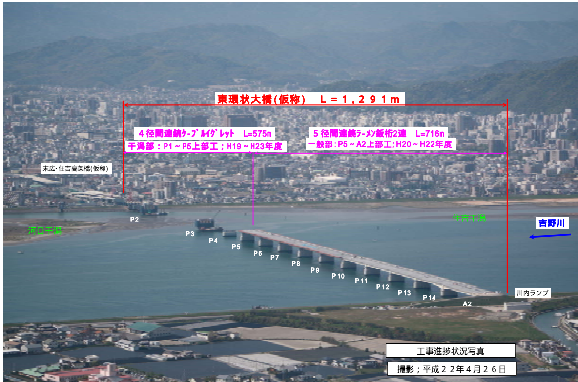
写真 1 工事区域全景 上空より(平成 22 年 4 月)
