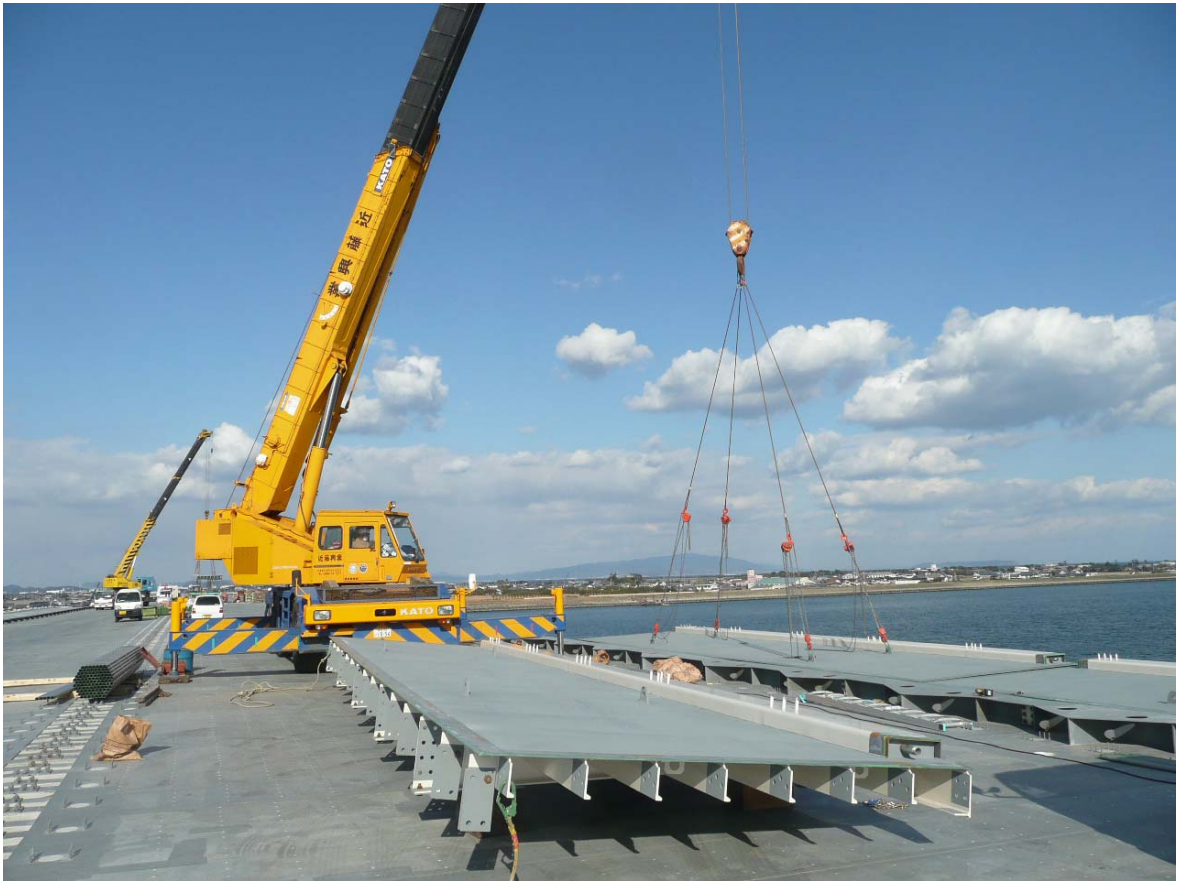
写真4 歩道部鋼床版架設作業状況(一般部) (平成22年2月3日)
