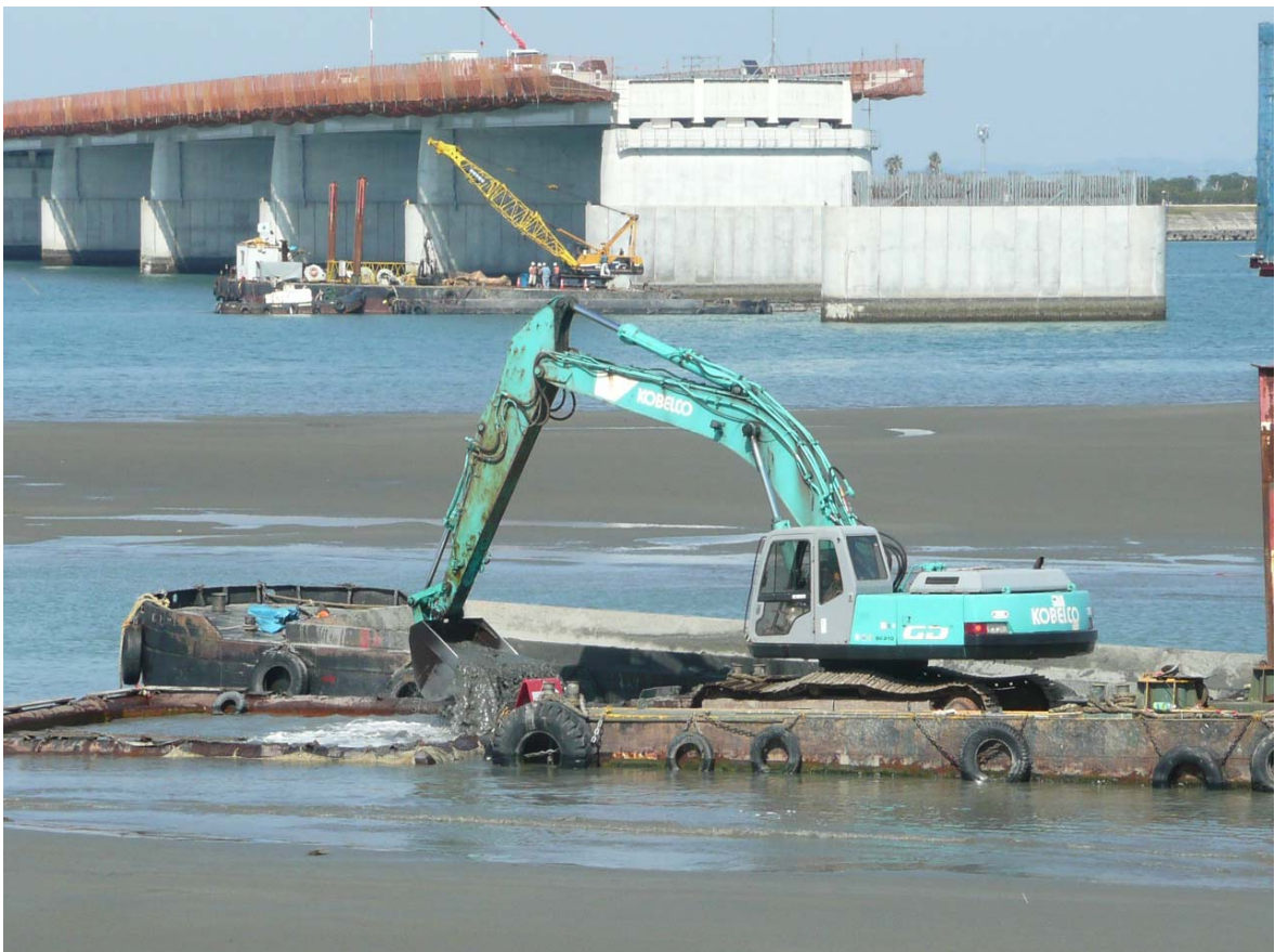
写真 11 航路浚渫作業状況(河川内) (平成 22 年 3 月 19 日)
