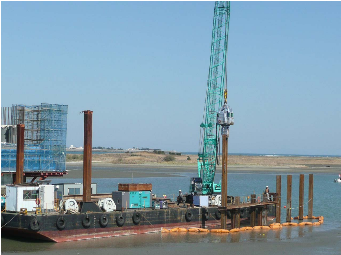
写真 10 ベント杭施工作业状況(干潟部：B6) (平成 22 年 3 月 19 日)
