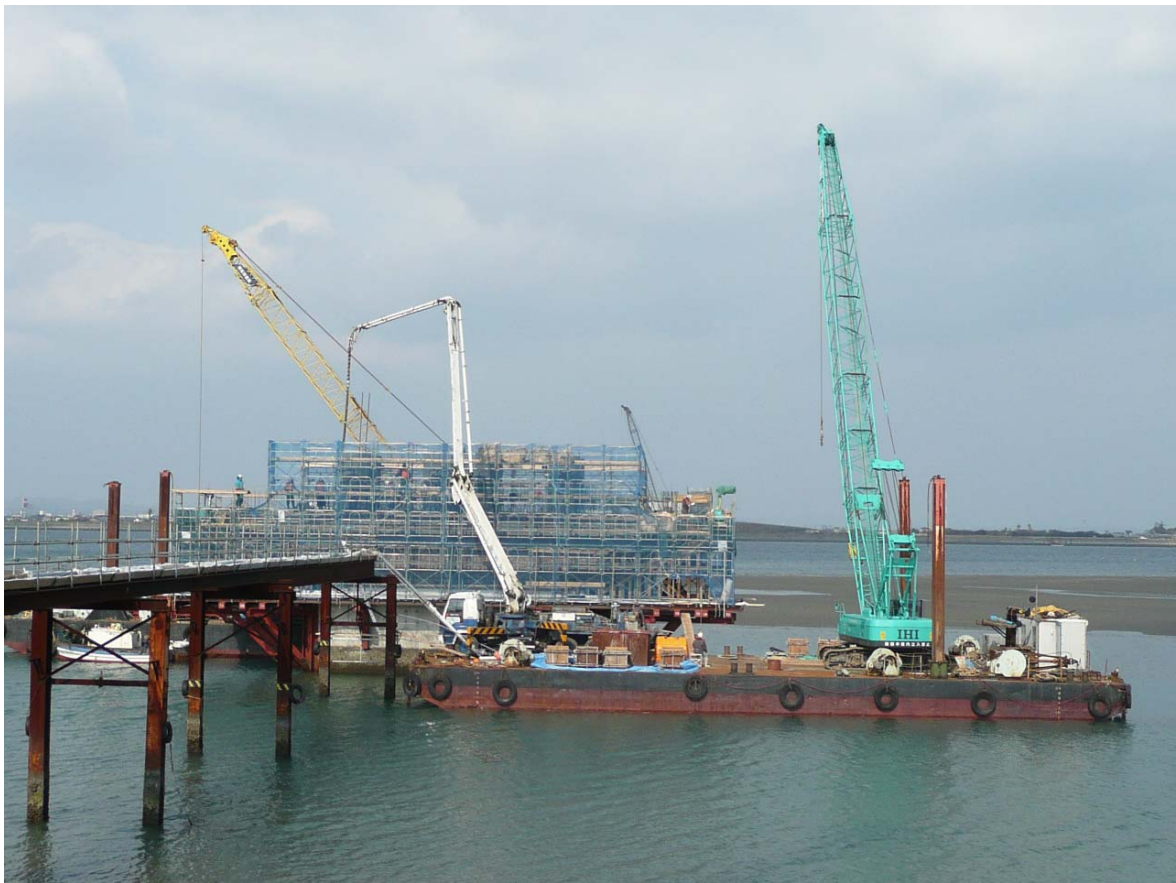
写真6 コンクリート打設作業状況(干潟部:P2) (平成22年2月18日)
