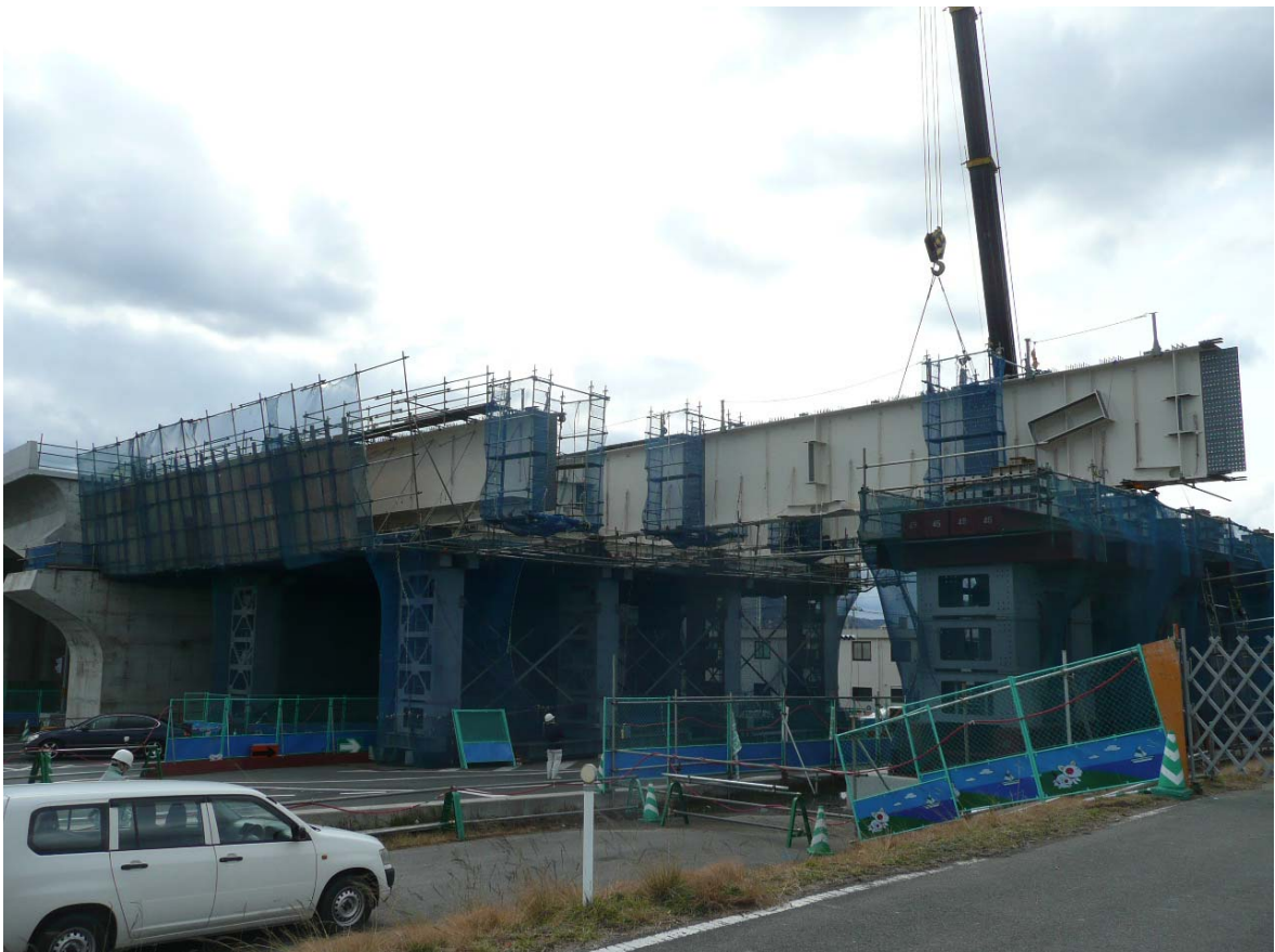
写真5 主桁架設作業状況(干潟部：県道上) (平成22年2月16日)
