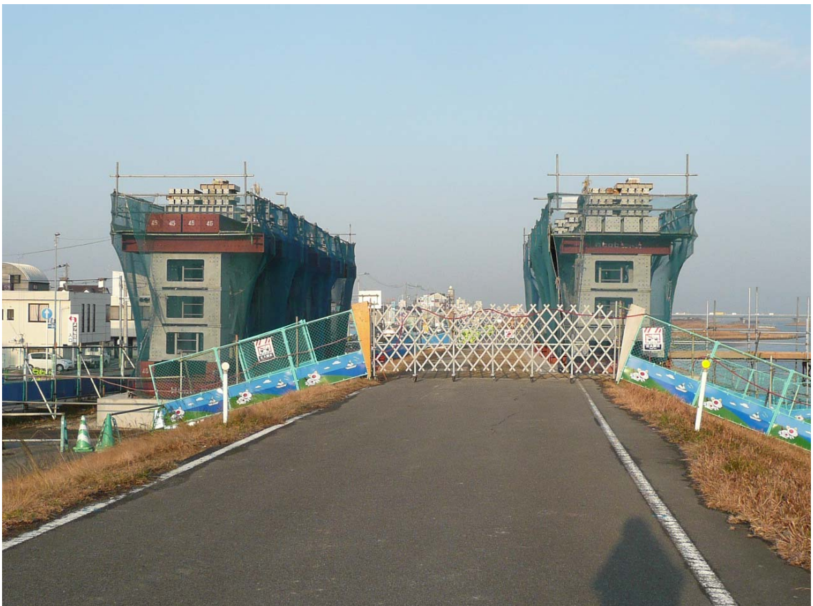
写真3 ベント設備作業状況(干潟部:B3,B4) (平成22年1月26日)
