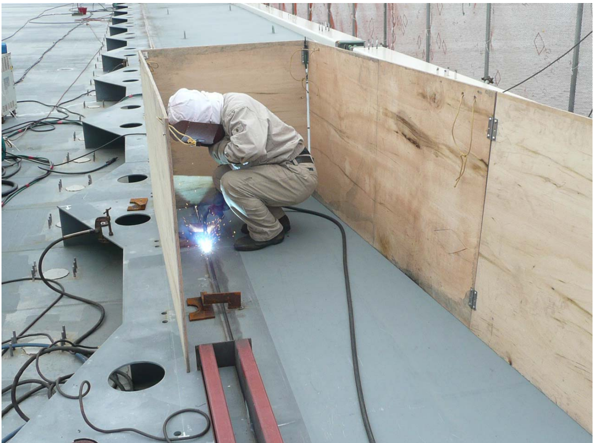
写真9 鋼床版現場溶接作業状況(一般部) (平成22年3月8日)
