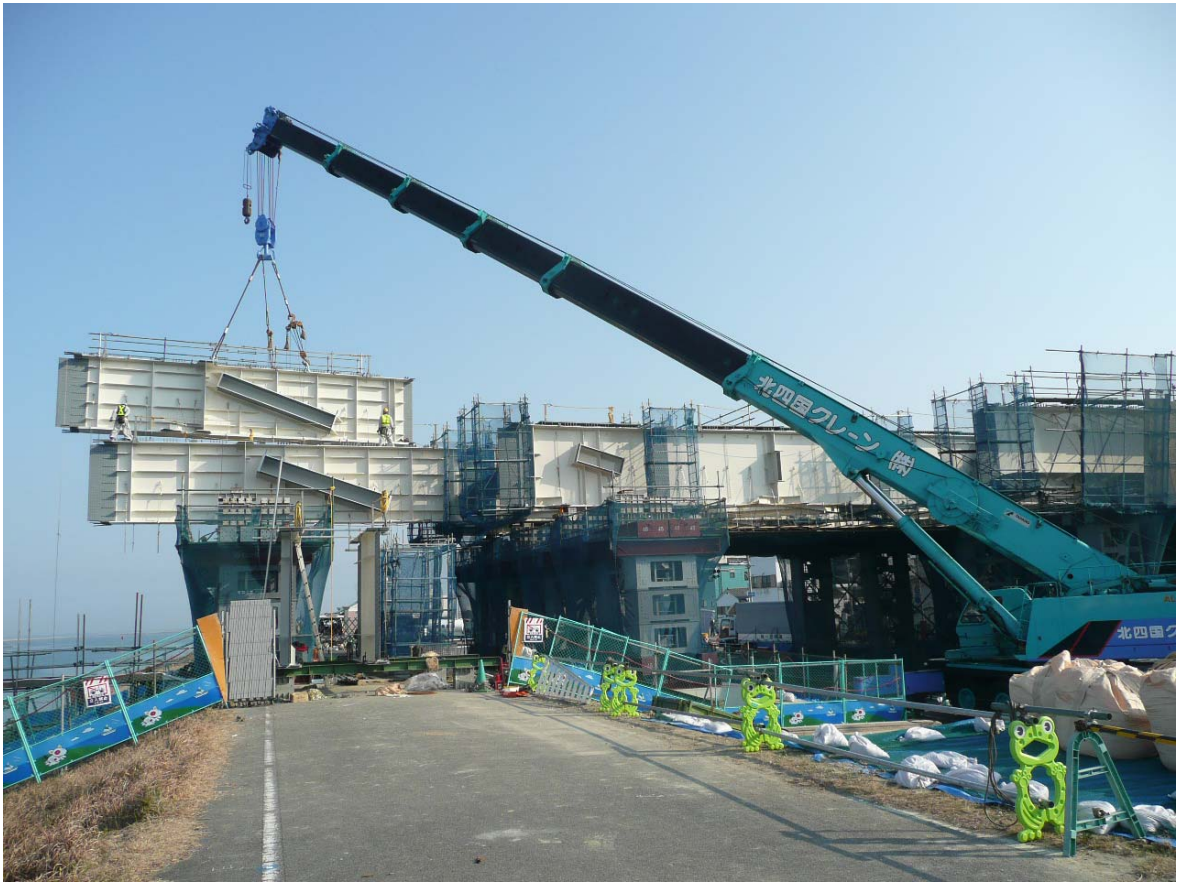
写真8 主桁架設作業状況(干潟部：堤防上) (平成22年2月23日)
