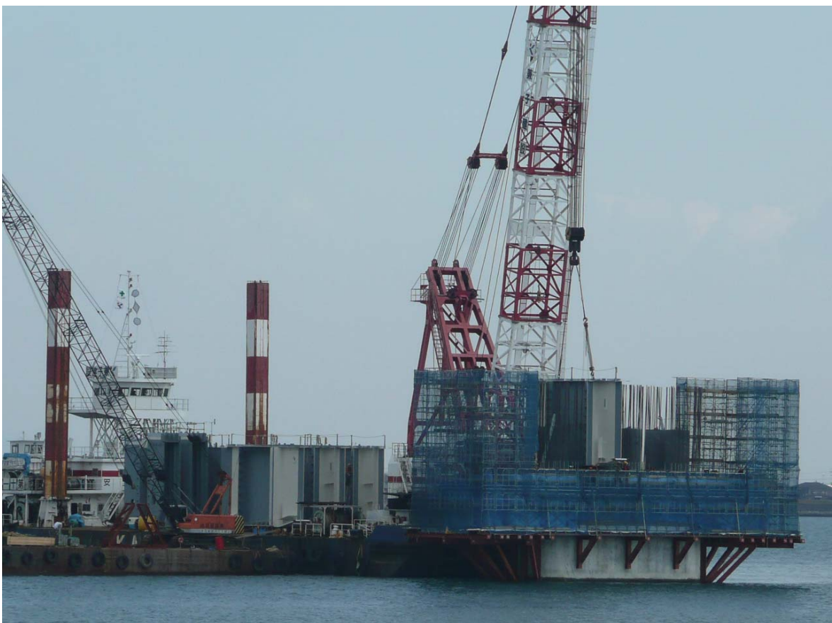
写真7 剛結部桁架設作業状況(干潟部:P3) (平成22年2月20日)
