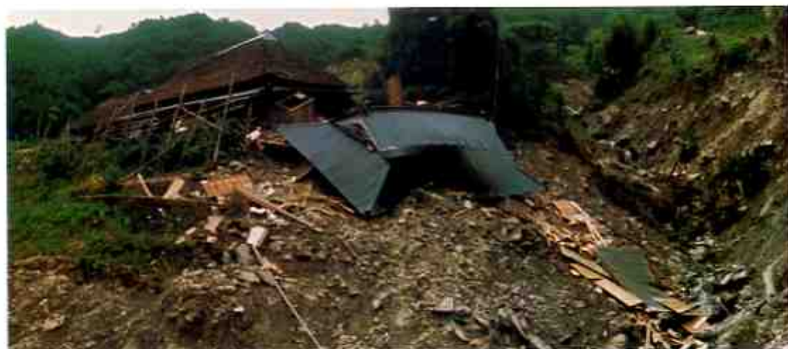
土石流により人家破壊 穴吹町内田地内
