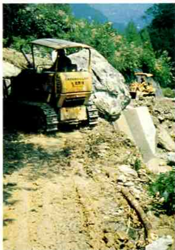
美馬郡木屋平村林道控原線 応急復旧作業,
