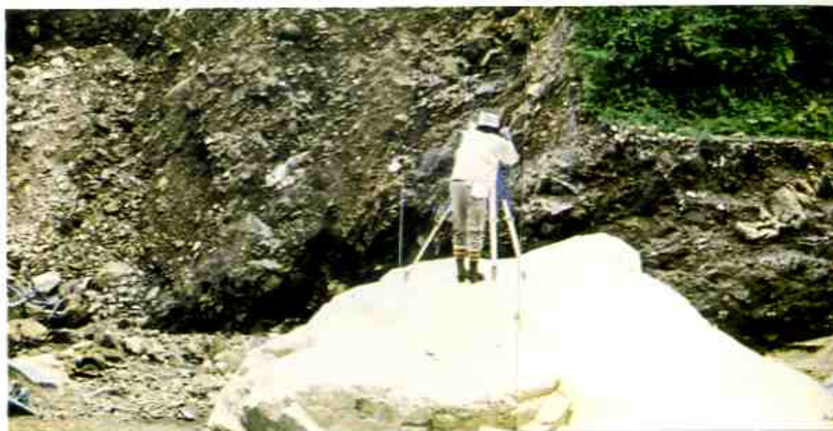
林道久井谷線 災害復旧の測量作業状況。
