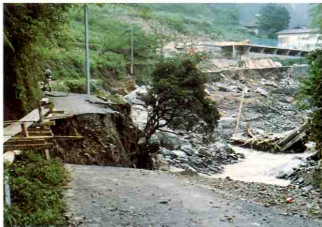
美馬郡穴吹町林道内田線
