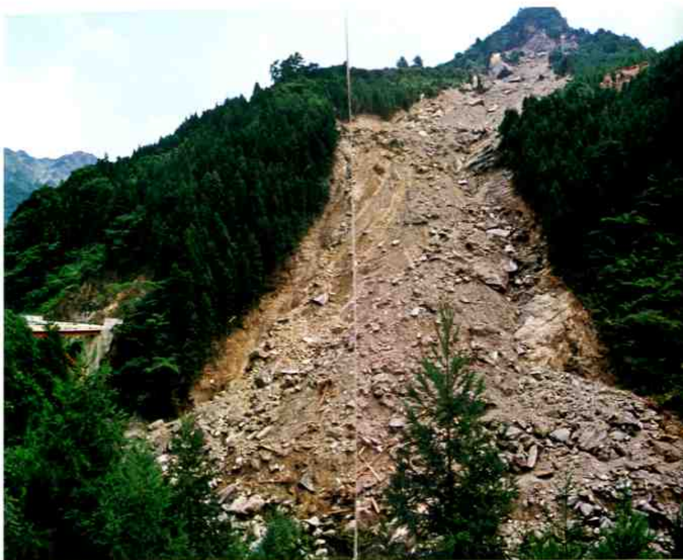
上部風化岩の崩落により立派な 成林地も無惨に崩壊し、河川に 多量の土石を流出した。 美馬郡穴吹町口山宇四谷地地内
