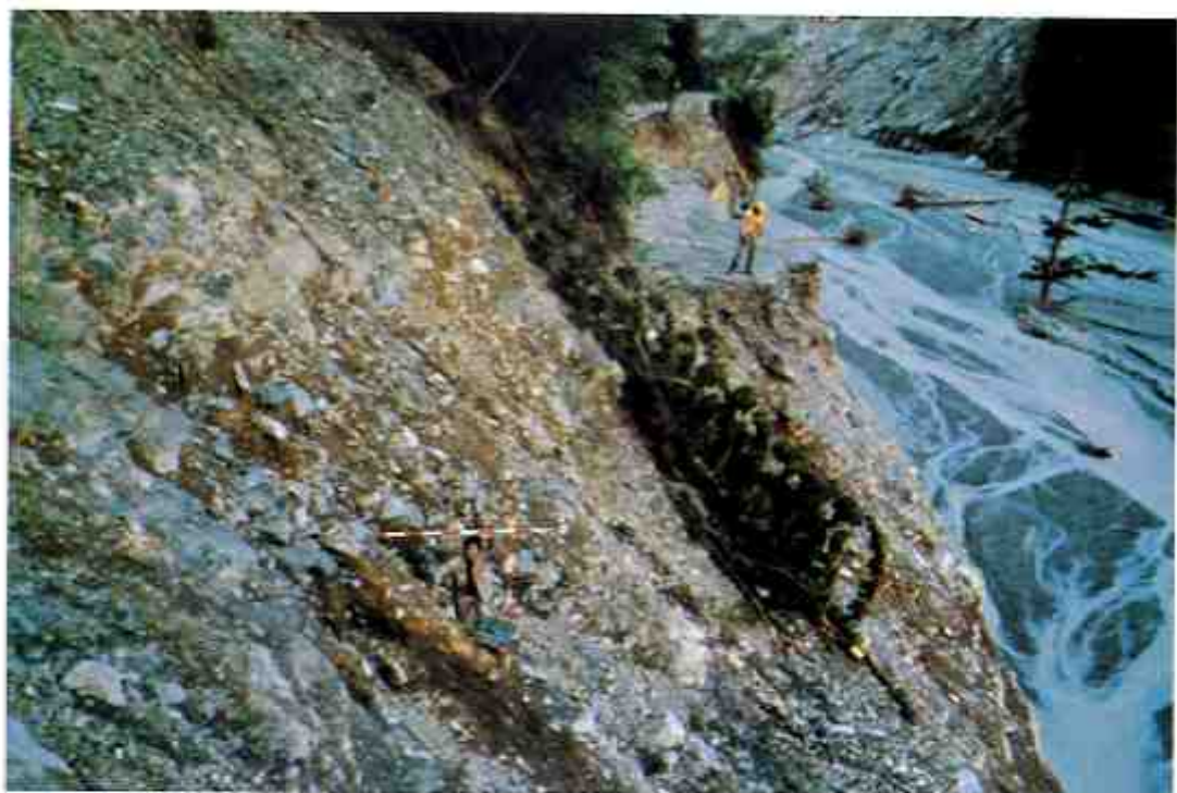
那賀郡木沢村林道槍戸線 土石流により全線にわたり欠壊埋没した。
