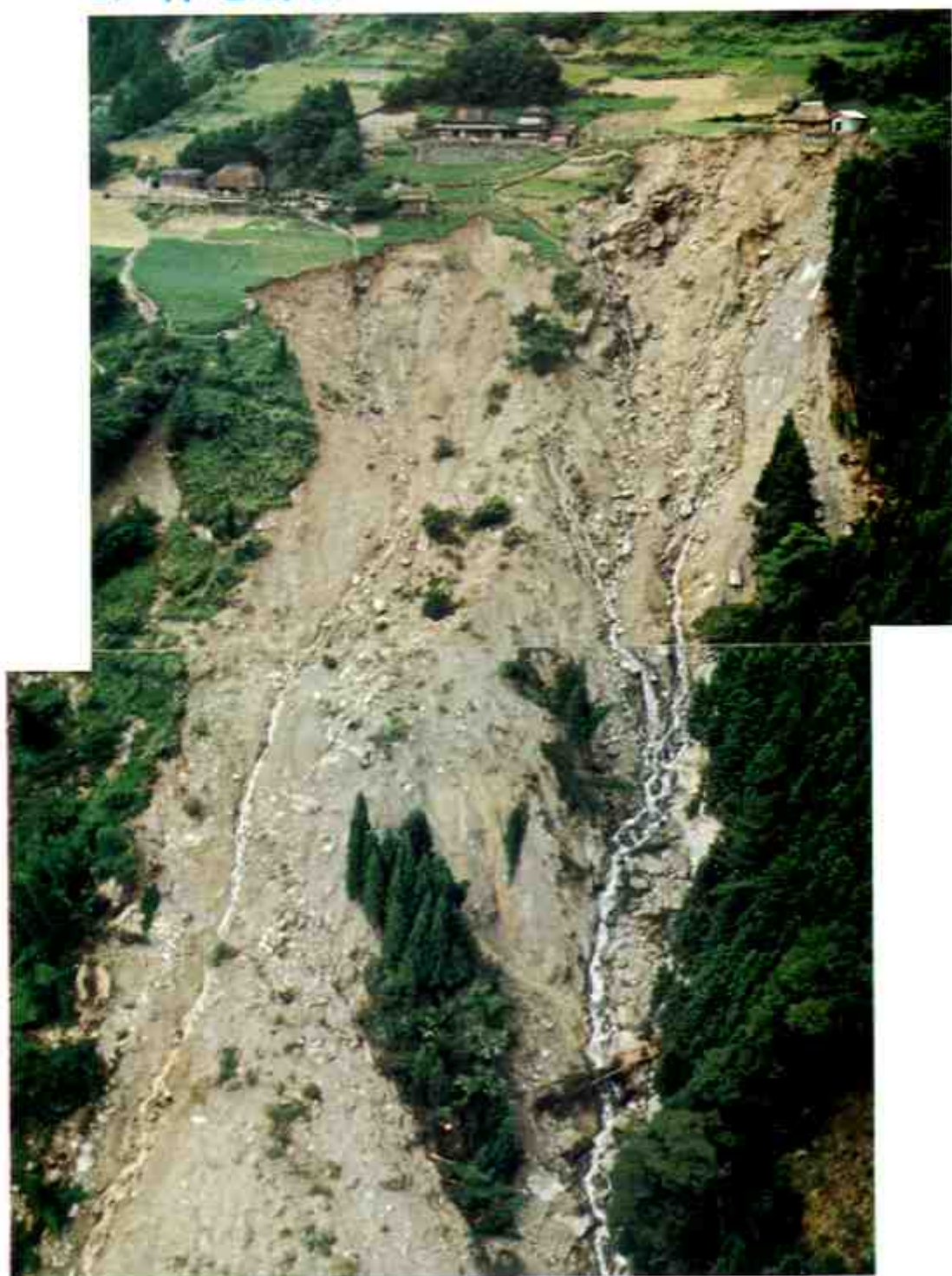
穴吹町内田地内大崩壊 表土が深い耕作地周辺で発生した崩壊は大規模である。
