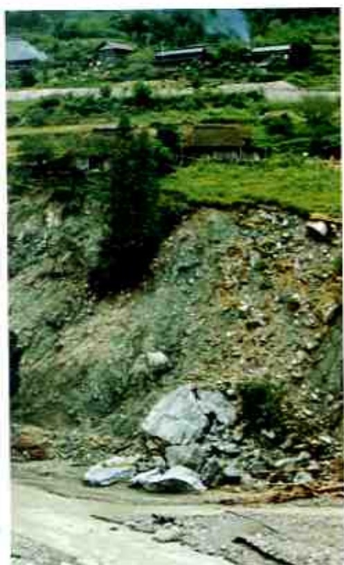
上流に発生した無数の崩壊 地から流出した土石流は溪 床を異状に上げて各所で溪 岸浸蝕崩壊を起した。
