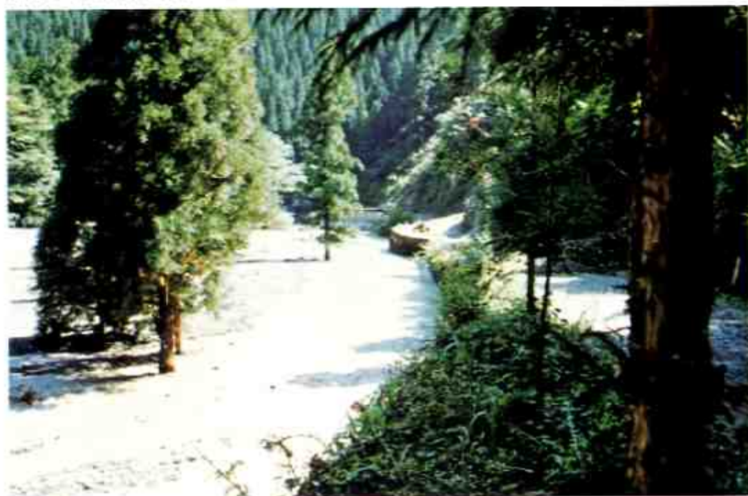
那賀郡木頭村林道折宇谷線中流部
