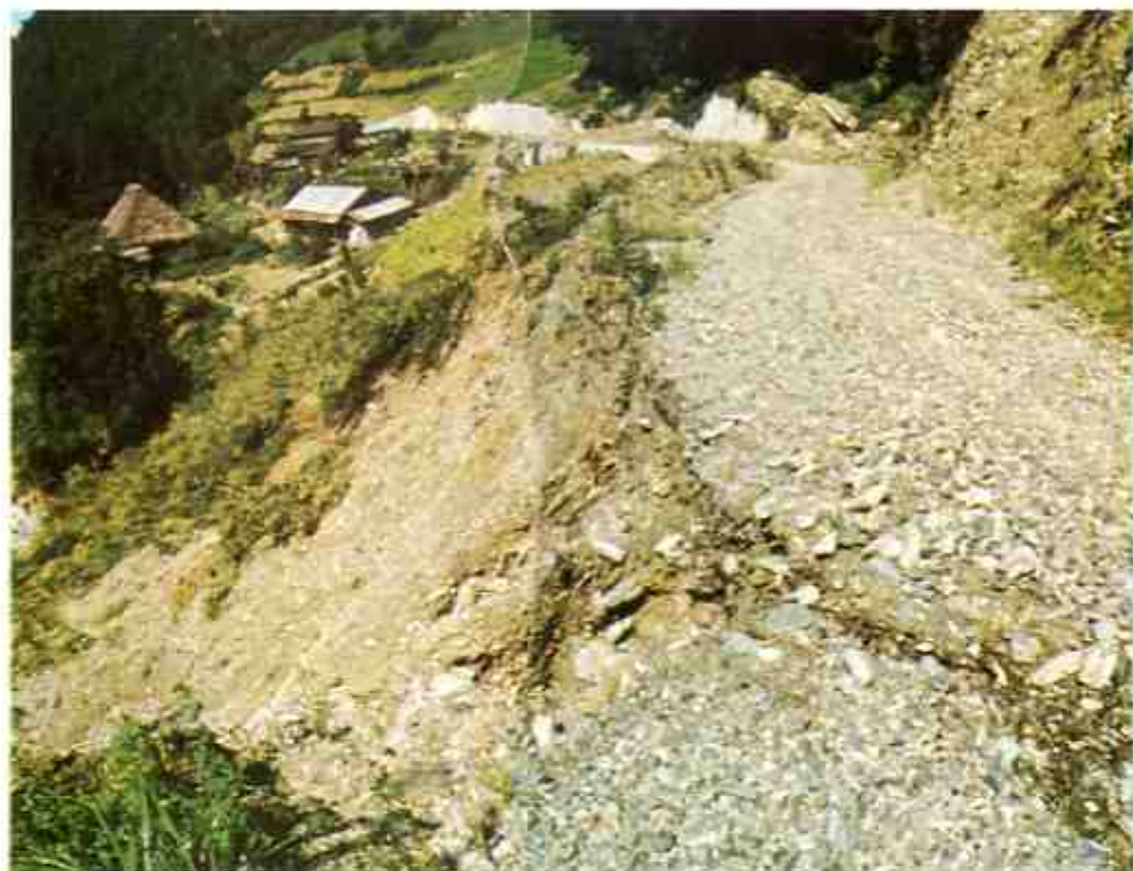
美馬郡一宇村林道太合実平線 地すべりによる欠壊。
