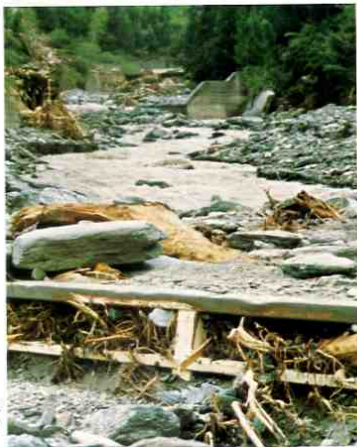
美馬郡穴吹町林道杖立線 林道内田線から望む。河 床が約9m上っている。
