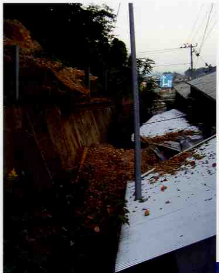
▲【美馬市鵜町佐尾原地区】崩壊土砂が、製材所を直撃した。
