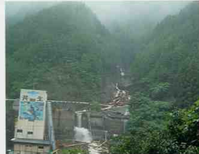
▲【那賀町木沢追立地区】 崩壊土砂が、町道、生コン工場に被害を及ぼした。
