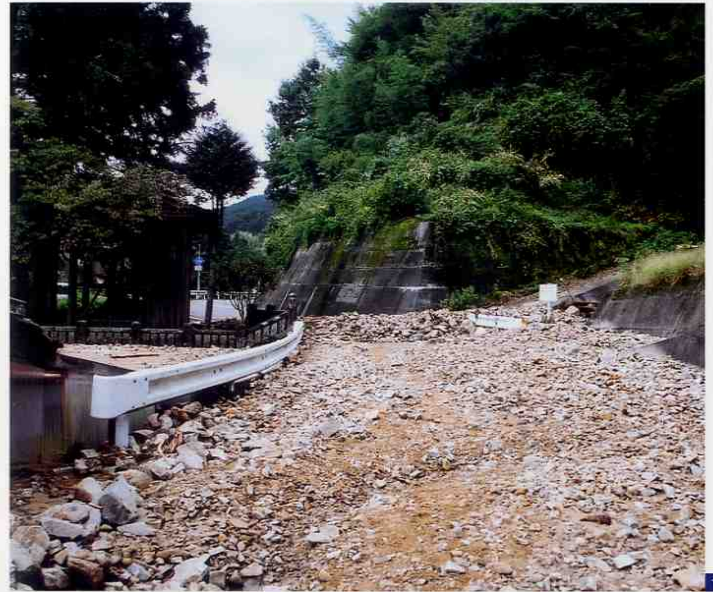
▲【池田町野呂内地区】崩壊土砂が国道を数カ所遮断した。
