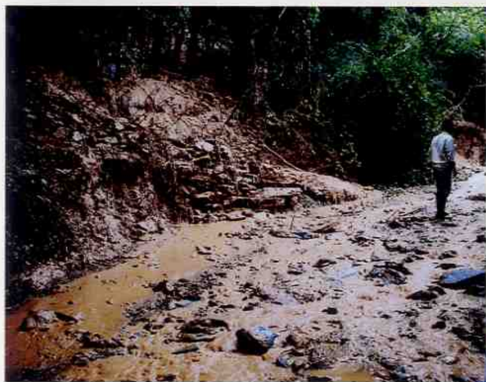
▲【井川町片山地区】崩壊土砂は、崩壊面中腹にある町道を遮断した。
