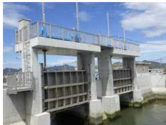
喜来中須入江川排水樋門 (松茂町喜来地区)
