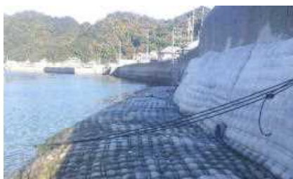
海岸整備 (土佐泊漁港海岸・護岸)
