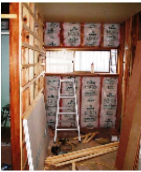
〔省エネ改修と耐震改修の同時施工イメージ〕
