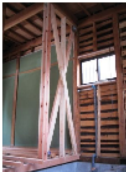
〔省エネ改修と耐震改修の同時施工イメージ〕
