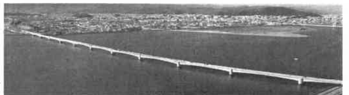
吉野川サンライズ大橋 徳島南部自動車道R55の吉野川河口に架かる吉野川サンライズ大橋(全長1,696.5m)が令和4年3月21日に開通し、徳島市中心部と京阪神方面が直接結ばれました。未開通の徳島津田IC～阿南ICの建設が進んでおり、早期開通を期待いたします。
