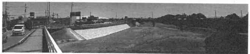
河川堤防の補強対策が実現 (法花大橋周辺)
