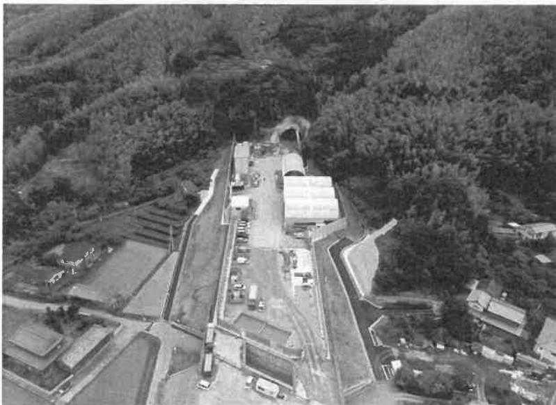
◀徳島南部自動車道羽ノ浦トンネル
