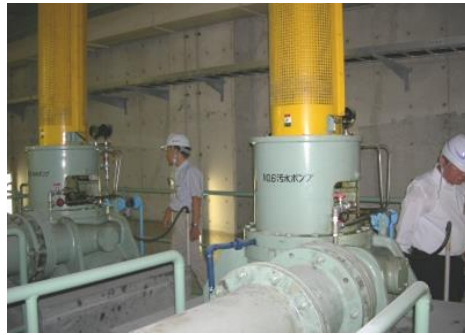
じょうか 浄化センターにある「ポンプ」 おすいかん 汚水管で集まってきた汚水を 地上にある池にくみあげています。
