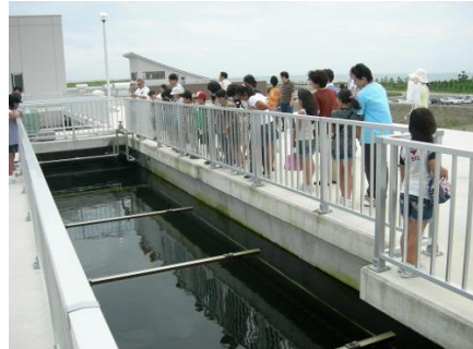
さいしゅう 「最終ちんでん池」とよばれる池 11～12ページの処理3(汚泥を しずめる処理)をしている池です。
