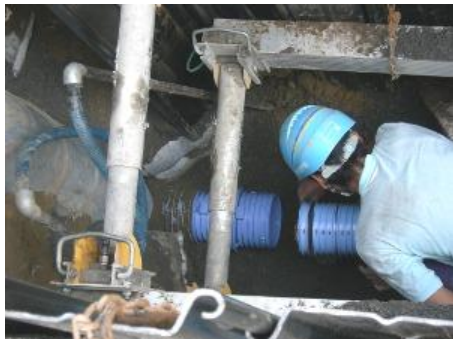
おすいかん 汚水管の工事 道路におすいかん 汚水管をうめます。
