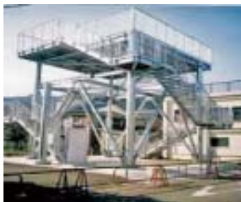
津波避難施設
