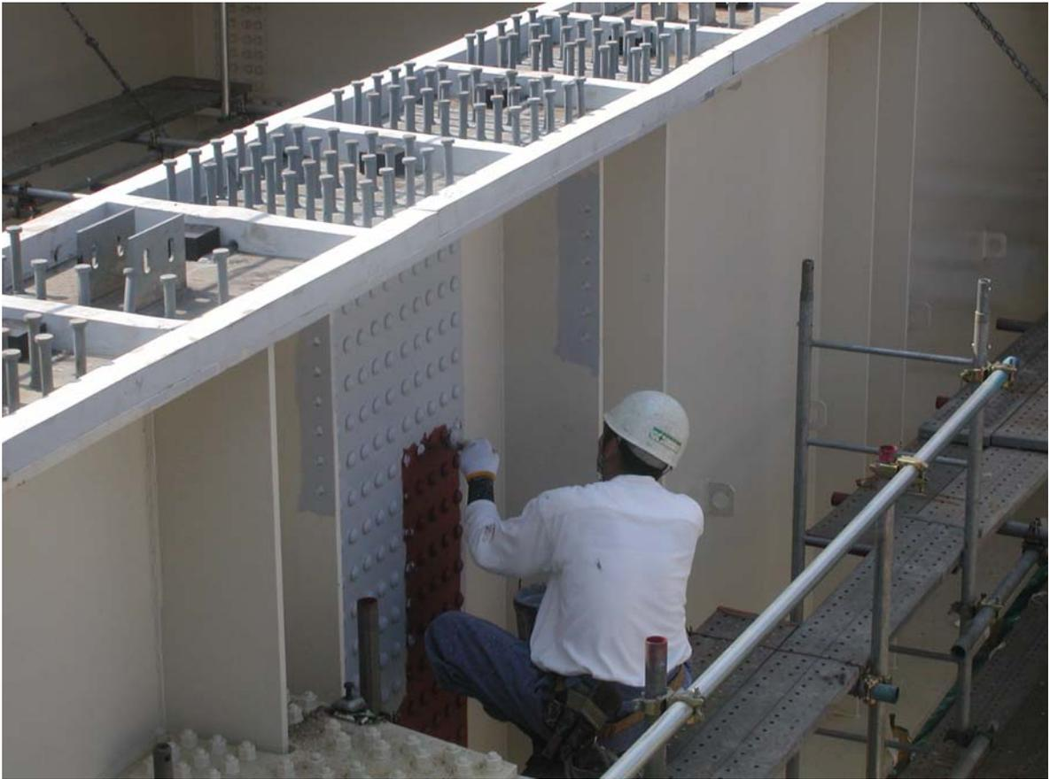
写真4 桁架設工事（一般部）：塗装作業状況（平成20年4月23日）
