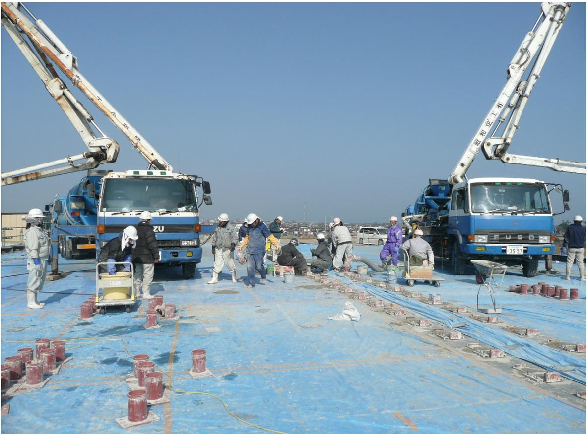
写真11 橋上工事（一般部）：SW床版打設作業状況（平成21年2月5日）
