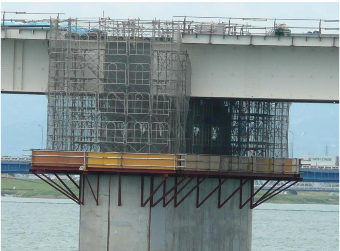
写真5 橋脚躯体工（一般部）：P13橋脚足場（平成20年5月30日）
