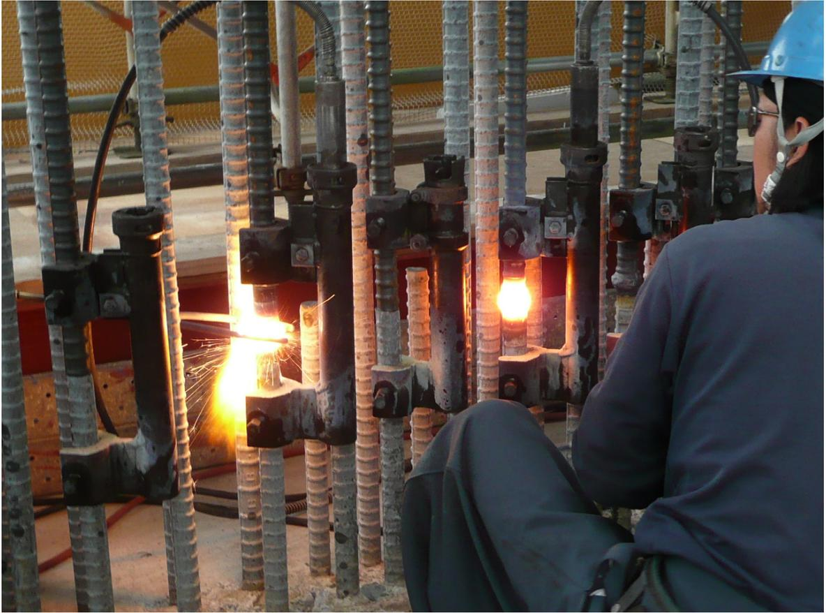
写真6 橋脚躯体工（一般部）：P7 圧接作業状況（平成20年10月17日）
