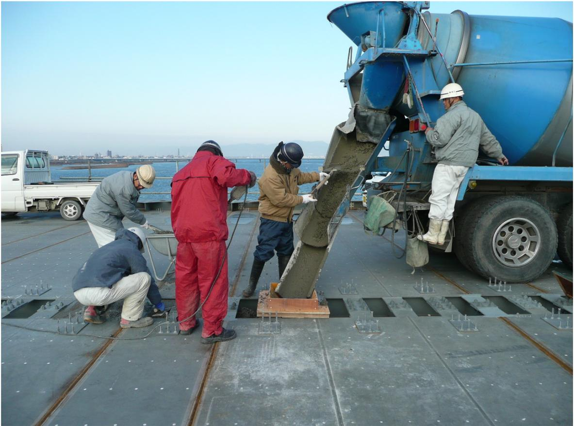
写真10 橋上工事（一般部）：中央分離帯打設作業状況（平成20年12月24日）
