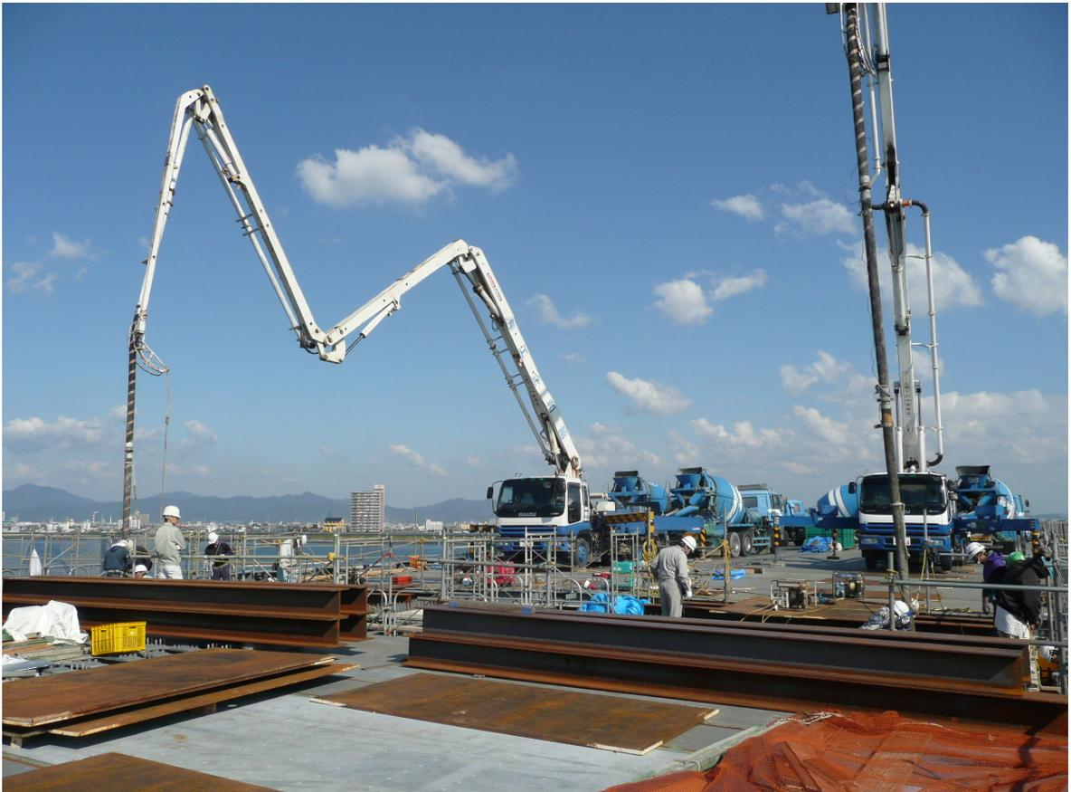
写真7 橋脚躯体工（一般部）：P6 橋脚打設作業状況（平成20年10月28日）
