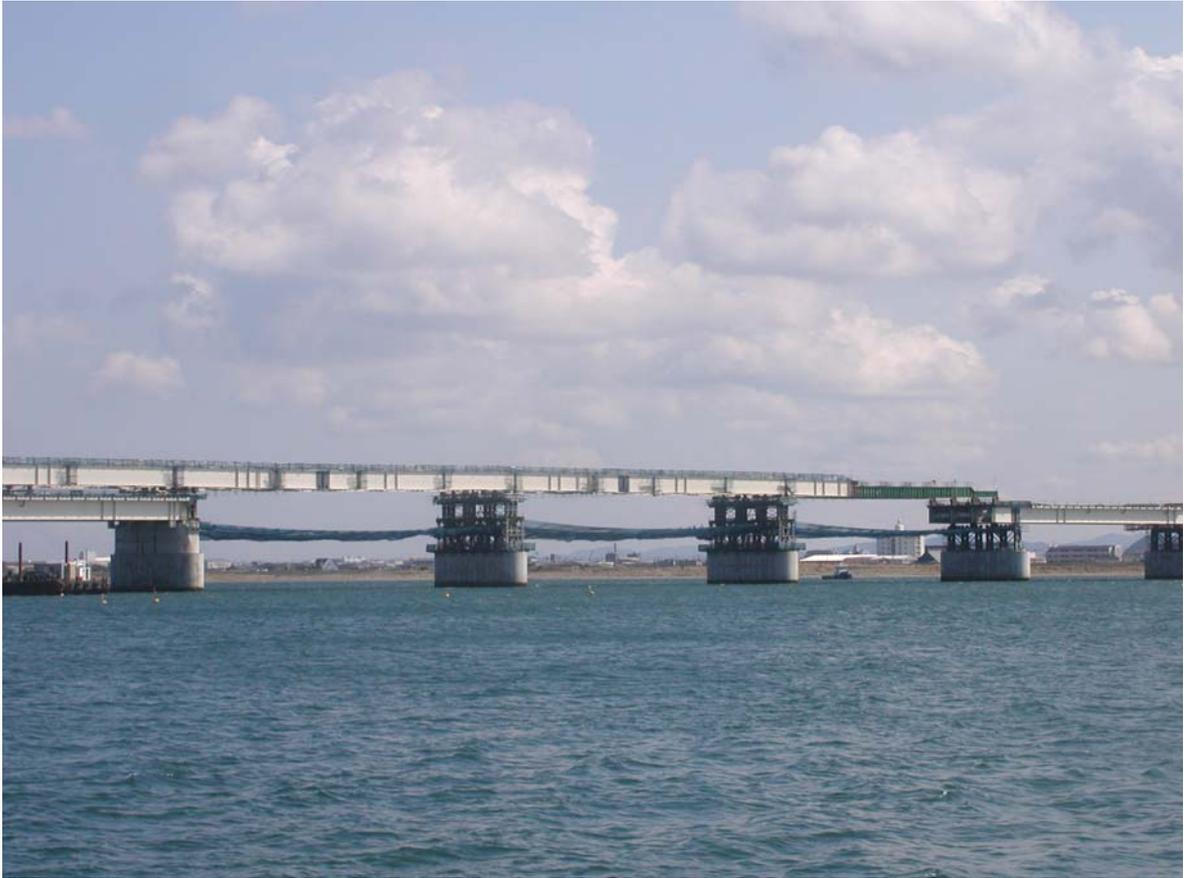
写真2 桁架設工事（一般部）：送り出し作業状況（平成20年4月1日）
