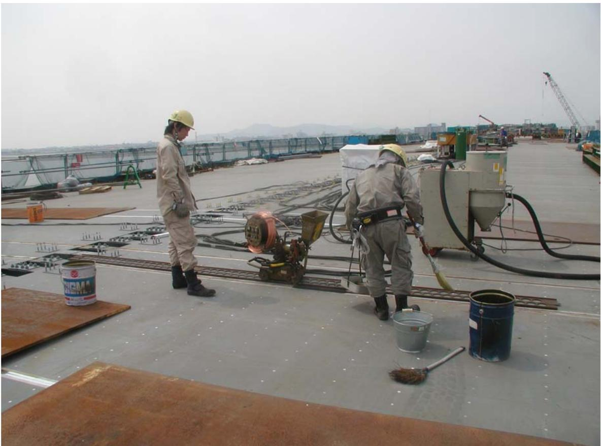
写真9 床版架設工（一般部）：SW床版溶接作業状況（平成20年4月28日）
