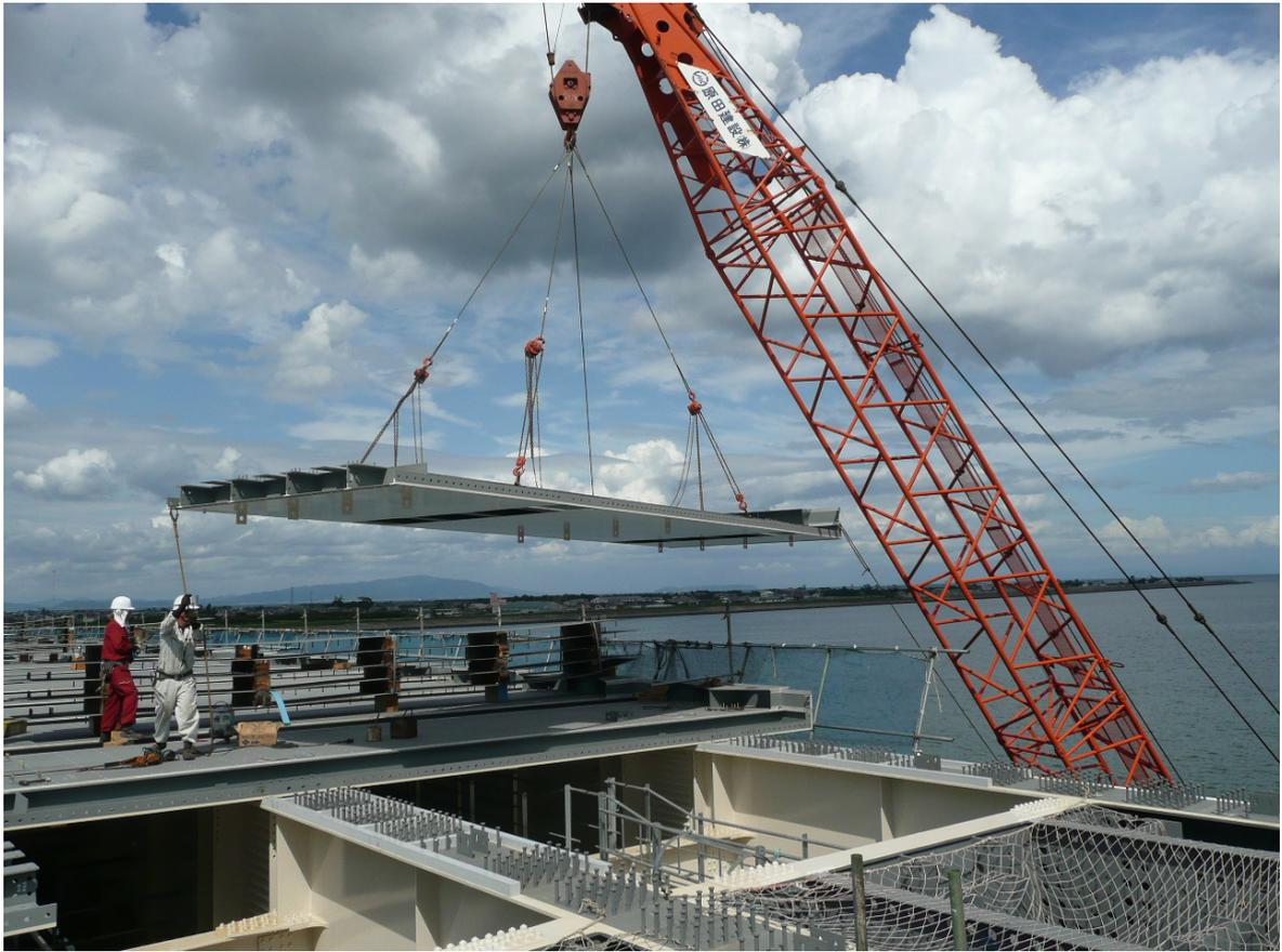
写真8 床版架設工（一般部）：SW床版敷設作業状況（平成20年8月21日）
