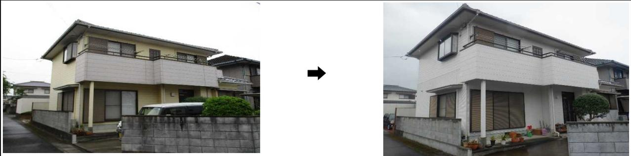
評点の低い住宅を評点1.0以上に改善。施主の要望で外部から補強工事が出来るよう計画しました、内部作業が少ない分工事は順調でした、工事内容は「1階耐震補強及び外壁張替」「2階外壁塗装」「破風、軒天塗装」「基礎樹脂注入」「感震ブレイカー設置」等を行いました。
