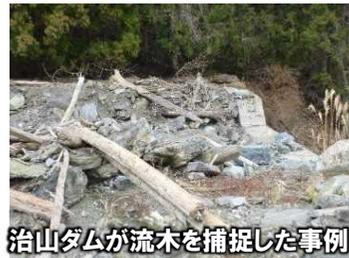
流木捕捉式治山ダム(スリットダム)やコンクリート治山ダムの整備により、下流への流木や土砂の流出を抑制
