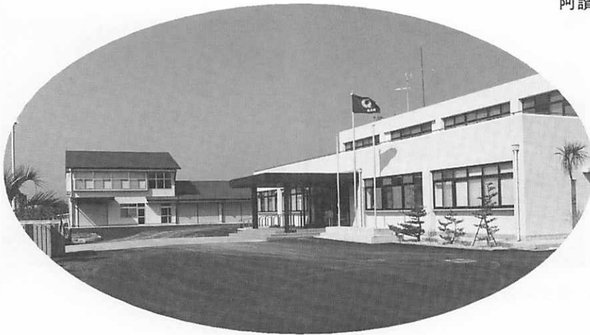
新館（分場） （昭和62年5月落成）
