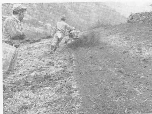
ユニバーサルロータによる揚土作業
