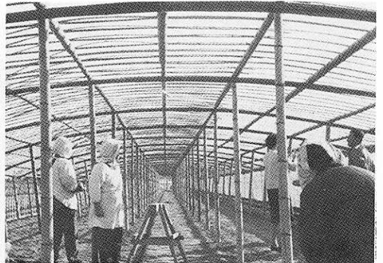
阿南地方の竹ハウスの建設（昭和35年）
