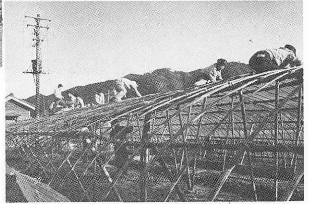
農試における竹製大型ハウス第1号の建設（昭和34年）
