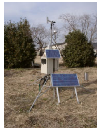
図2 気象観測システムの設置状況
