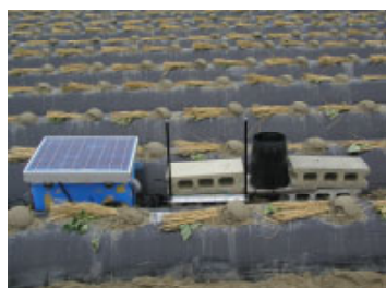
図3 土壌水分観測システムの設置状況
