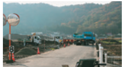
新拠点整備に向けたほ場改修工事
