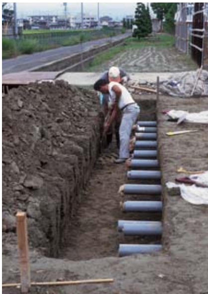
ハウス暖房用地中熱 交換パイプの埋め込み （昭和55年頃）
