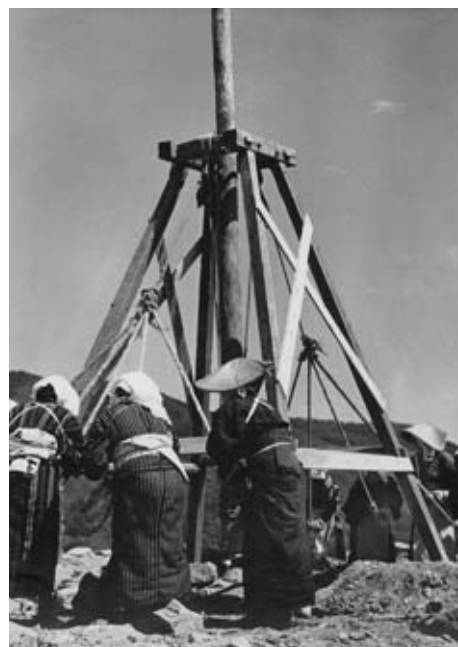
本館改築の地搗作業
