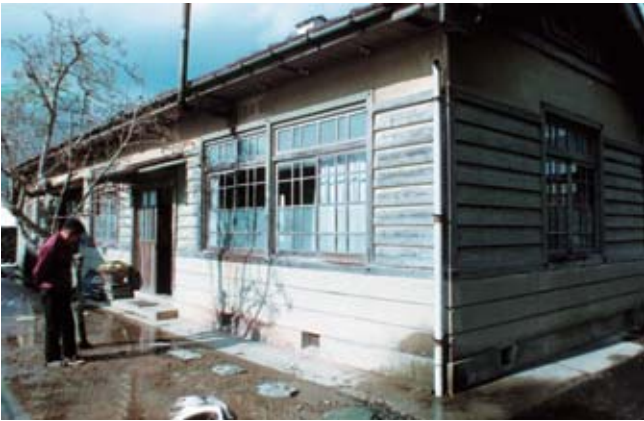
本館南面（昭和55年）
