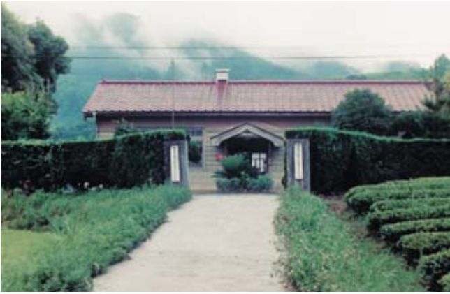
池田分場本館（昭和55年）
