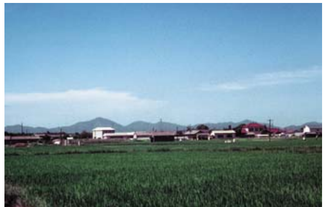
南側から見た全景
