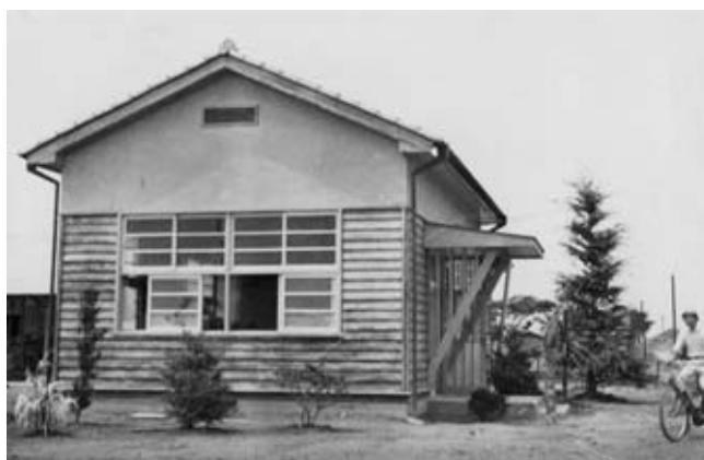
東側から見た藍住分場本館（同年）
