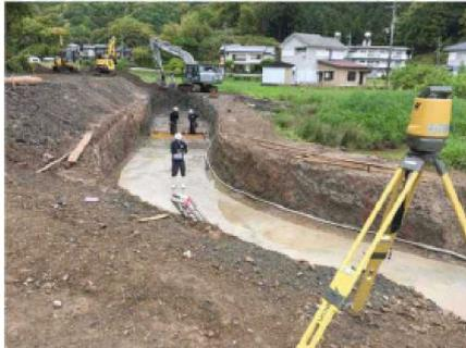
TSトラッキングUAS写真測量システム
