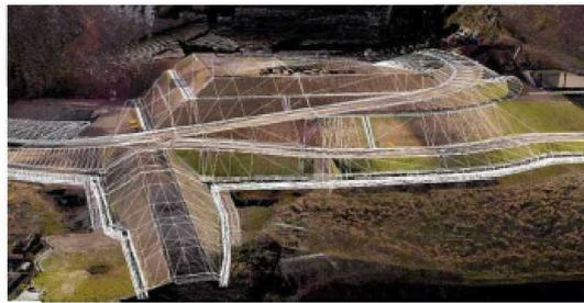
3次元設計データによる作業土工（床掘）を進めるMGバックホウとワンマン3次元測量
