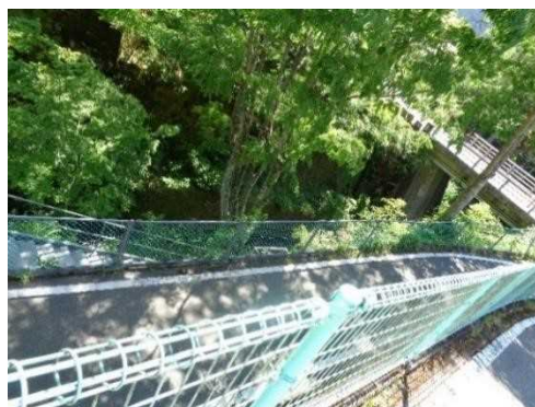
図-6 河川横の通路 取水に適切な溜りがある
