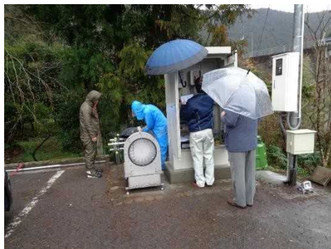
図-42 制御盤の作動確認
