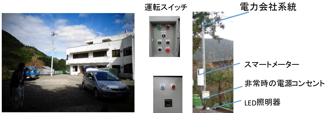
図-39 最も近い既設の電柱
