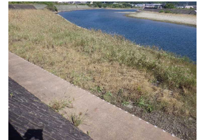
ナガボテンツキの群生箇所(R3年度工事影響はなし)
