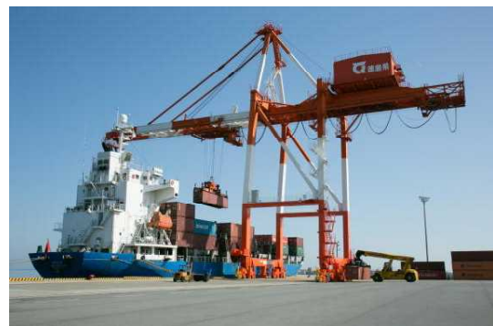
ガントリークレーン
