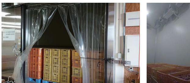
図1 キュアリング処理, 高温キュアリング処理の様子
