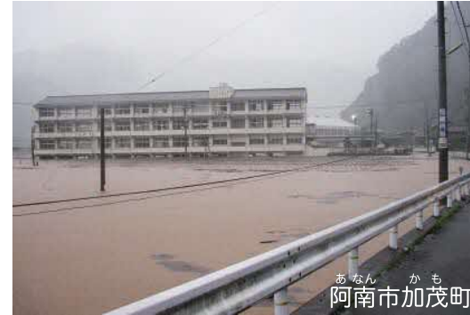
建物の1階部分が水ぼつした中学校 周辺では多くの住宅などがしん水
