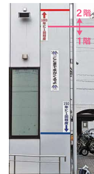
【想定されるしん水の深さを建物に示した例】
