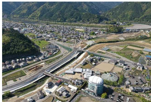
【那賀町和食地区河川浸水対策、輪中堤】
