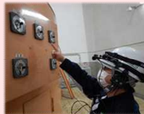
カメラを用いた点検
