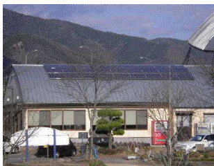
太陽光パネル設置施設
