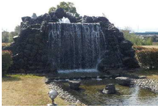
浄化用水ポンプ
