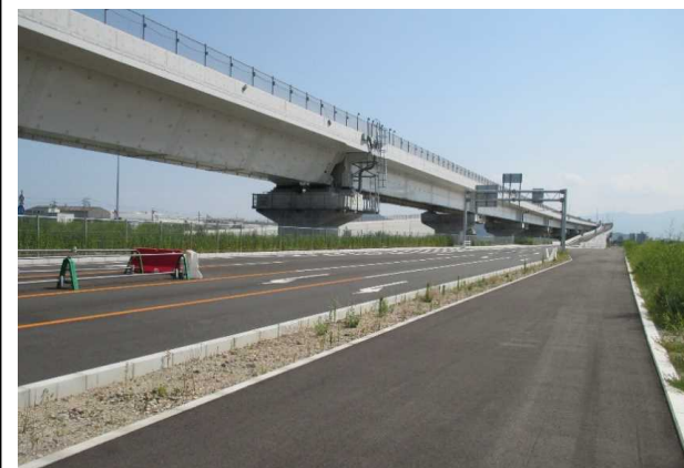
整備後 (一)徳島東インター線 北沖洲工区
