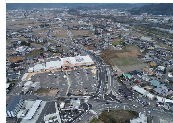
整備後 (主)小松島港線 江田工区
