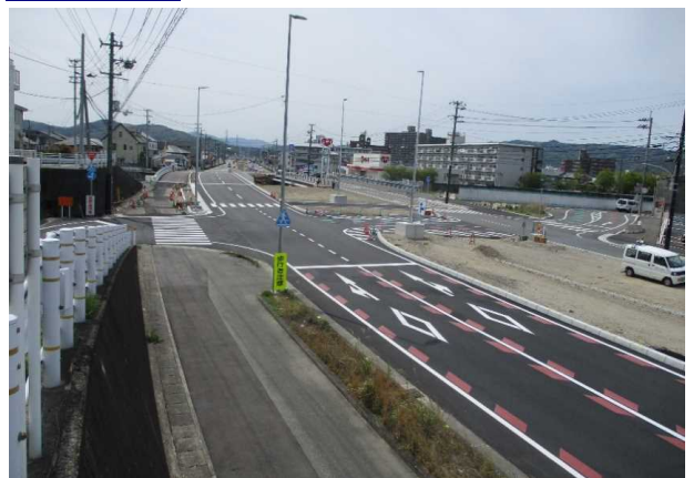
整備後 (主)徳島環状線 新浜～八万工区
