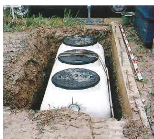
写真：設置状況
