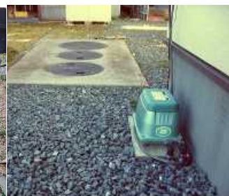
写真：設置完了
