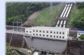
日野谷発電所
