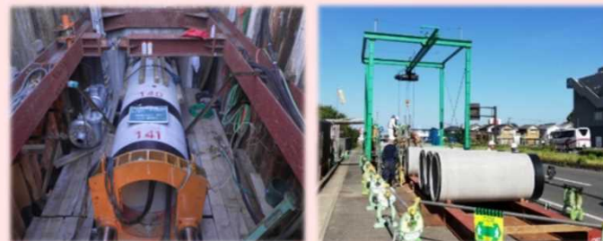
管路布設替工事の様子
