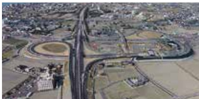
徳島インターチェンジ（徳島市）
