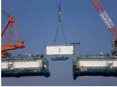
主塔の間の桁をつなげている様子
