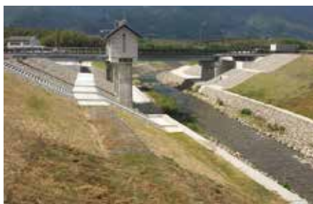
山口谷川堤防 （三好郡東みよし町）
