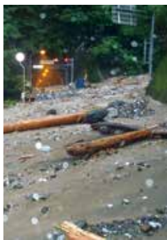
土石流により道路が通行止になっている様子
