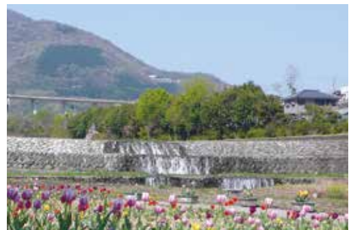
大谷川砂防堰堤 （美馬市）
