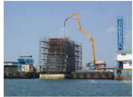
コンクリートを流し込んでいる様子
