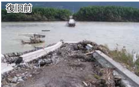
洪水で流れた橋の復旧
