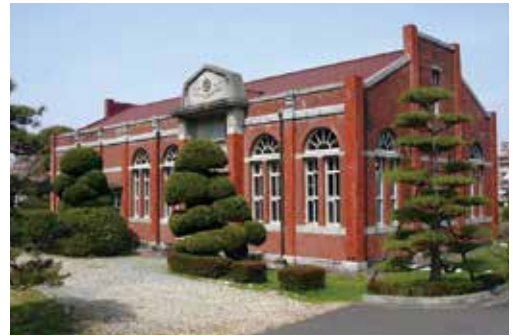
佐古配水場 旧ポンプ場 （徳島市）
