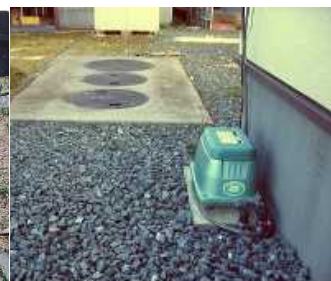
写真：設置完了
