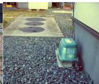
写真：設置完了
