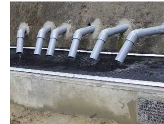
横ボーリング工
