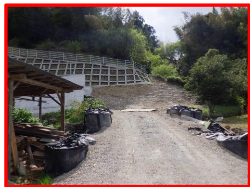
② D工区 擁壁工完成
