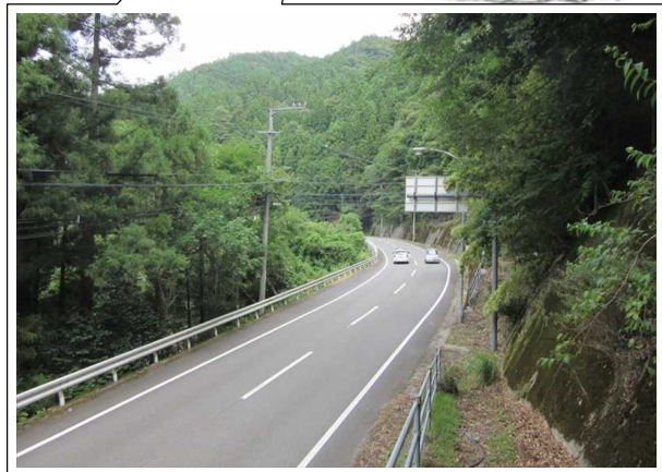
現道拡幅区間(H22.6月供用)
