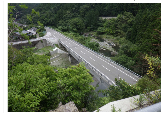
バイパス区間(R3.3月供用)
