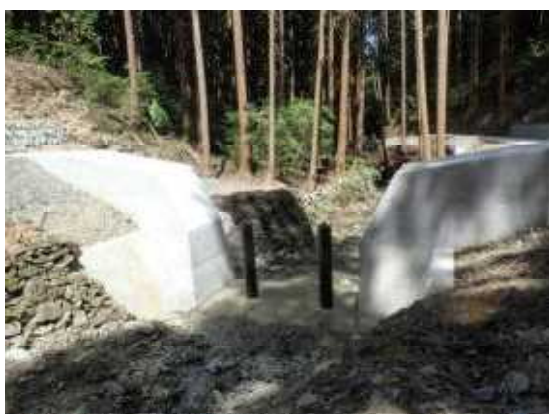
流木捕捉式治山ダムの設置
