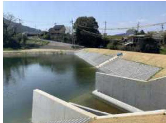
整備された農業用ため池
