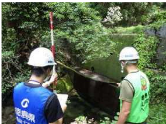
山地災害危険地区パトロール
