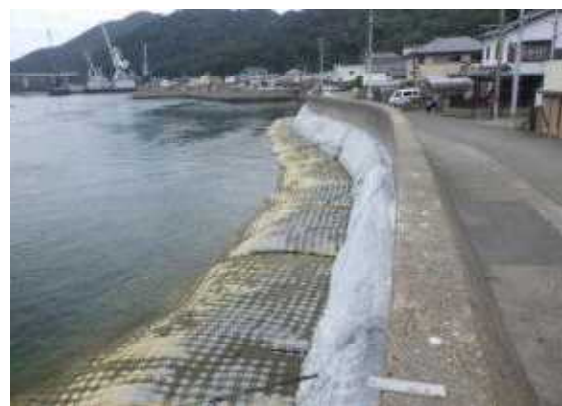
漁港海岸・護岸補強（整備後）
