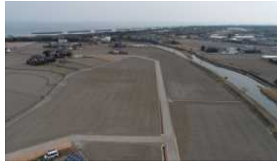
ほ場整備（芳崎地区）整備後
