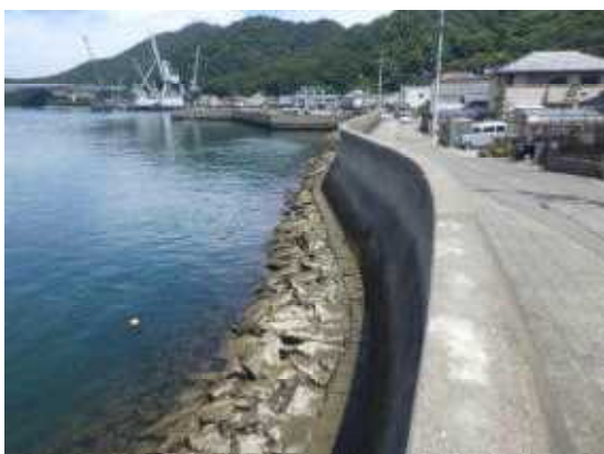
漁港海岸・護岸補強（整備前）
