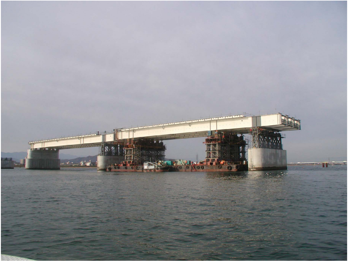
写真6 上部工(一般部):台船架設状況(平成19年12月)
