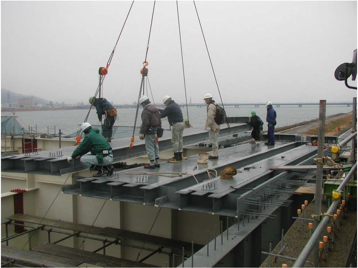
写真 10 上部工（一般部）：サンドイッチ床版設置状況（平成 20 年 2 月）
