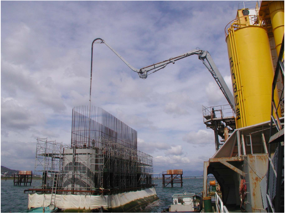
写真2 下部工(干潟部): P5 橋脚水中コンクリート打設状況(平成19年4月)
