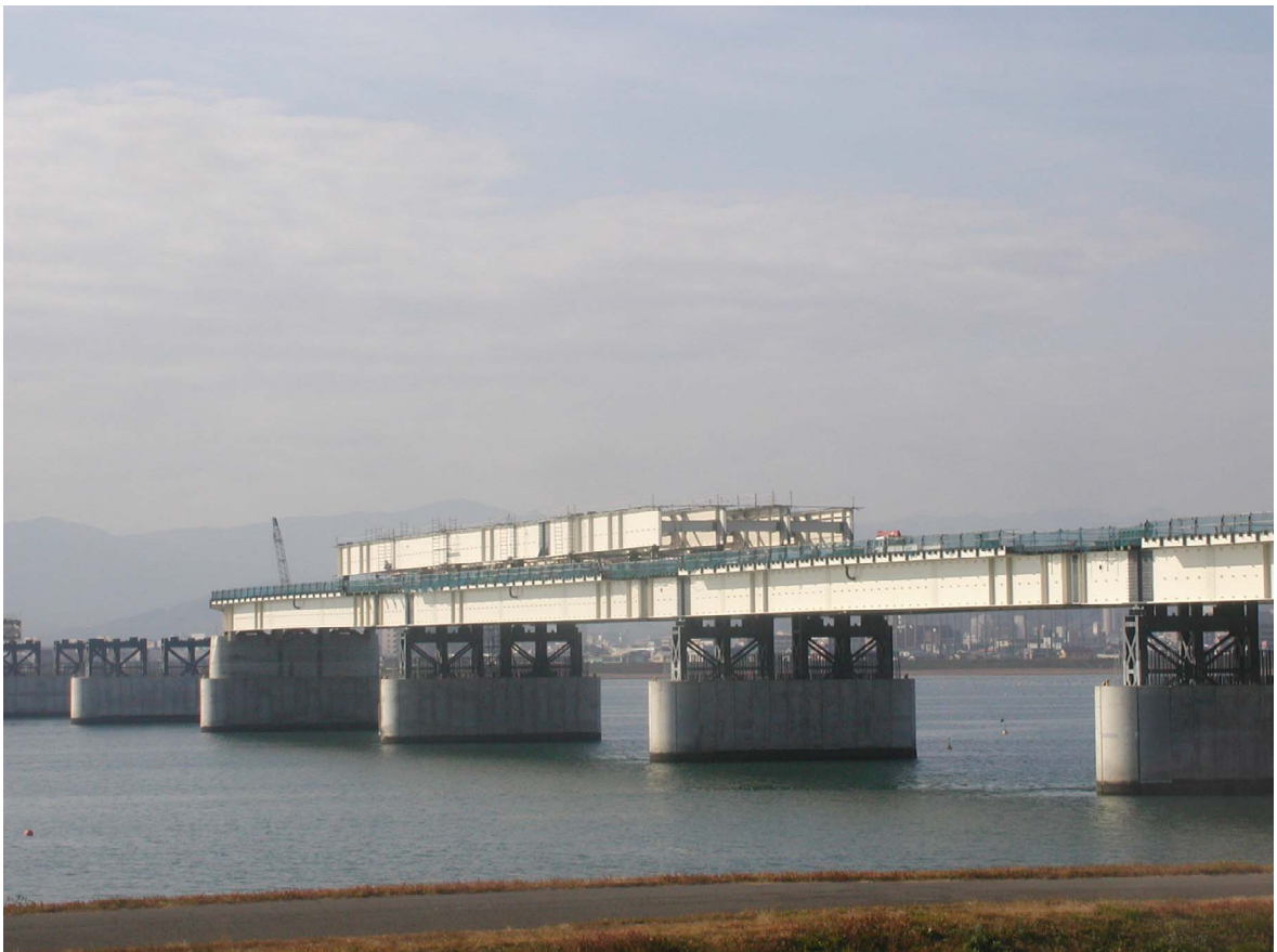
写真9 上部工（一般部）：桁上地組立状況（平成20年1月）
