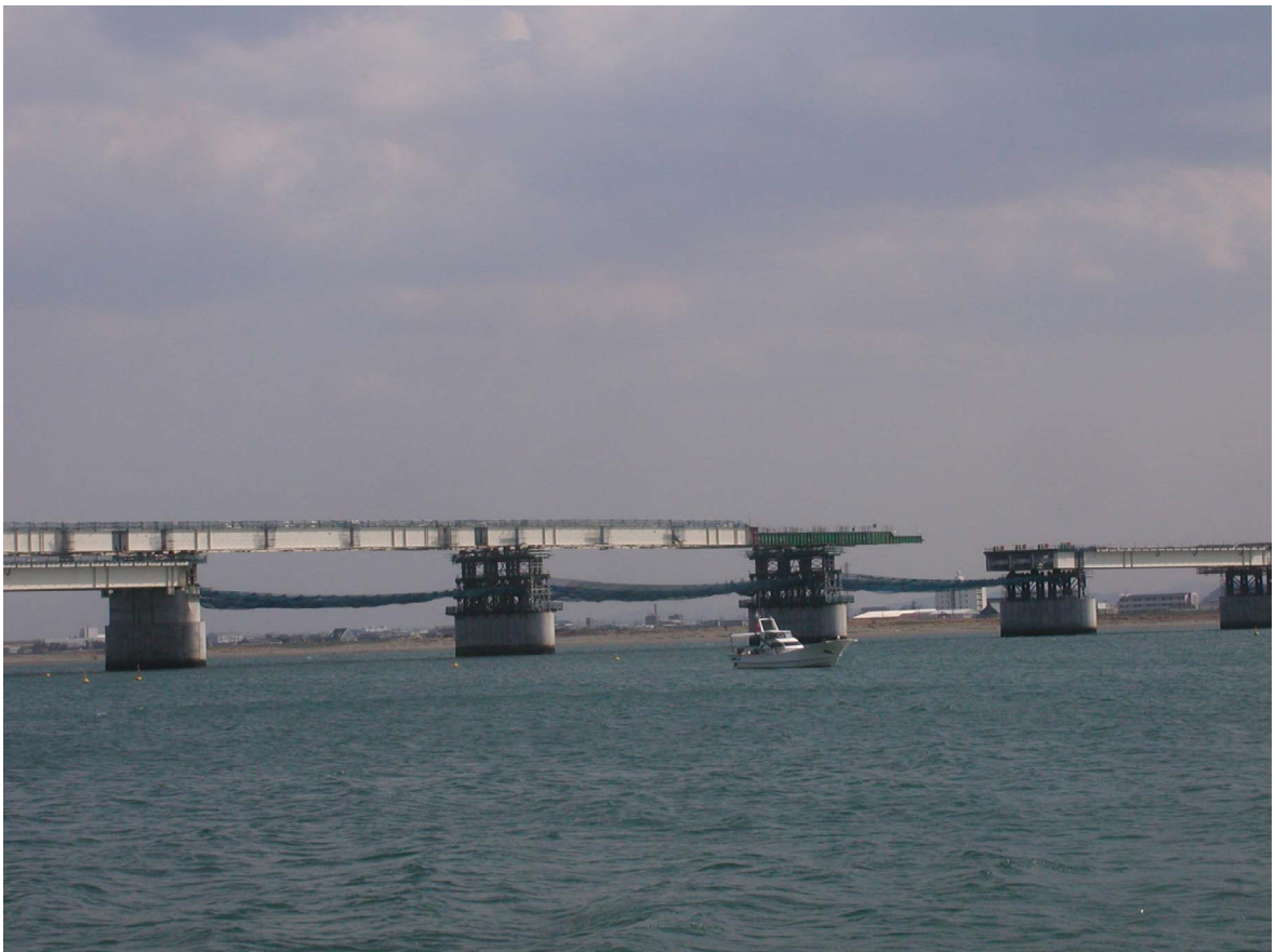
写真 11 上部工（一般部）：送り出し架設状況（平成 20 年 3 月）
