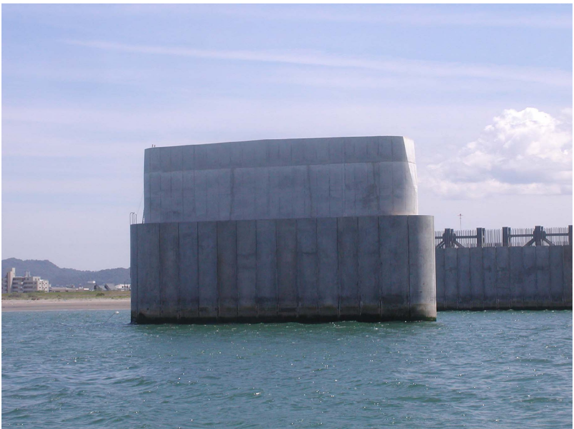
写真5 下部工(干潟部): P5 橋脚完成(平成19年6月)
