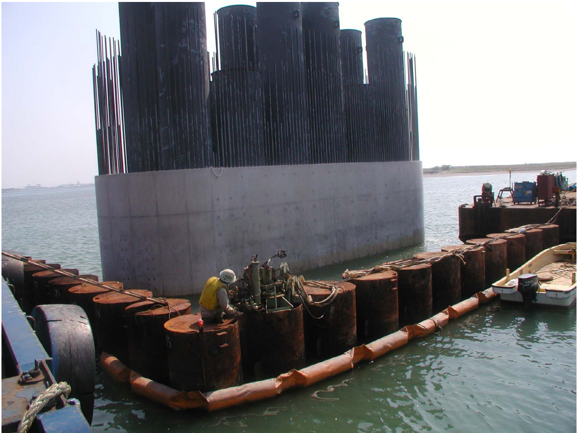
写真4 下部工(干潟部): P2 橋脚鋼管杭切断状況(平成19年5月)
