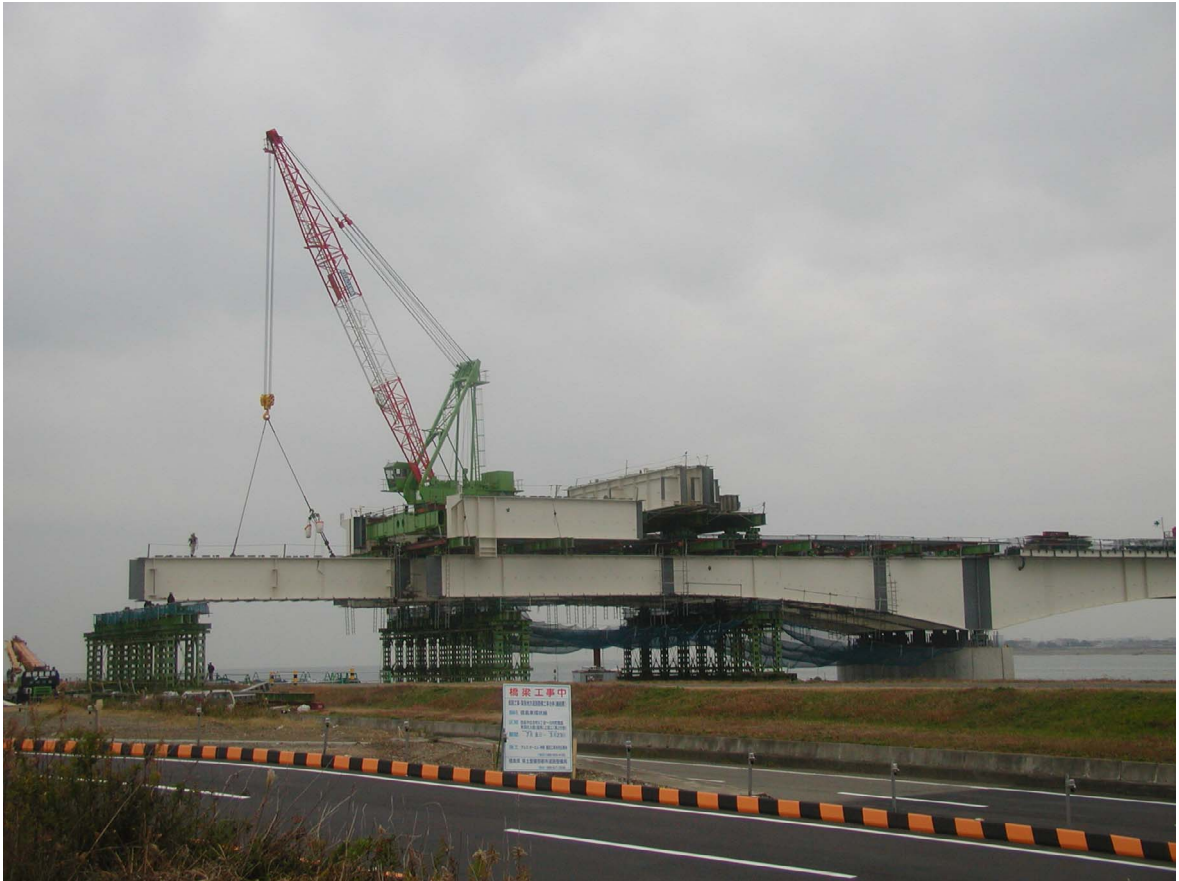
写真8 上部工（一般部）：トラベラークレーン架設状況（平成20年1月）
