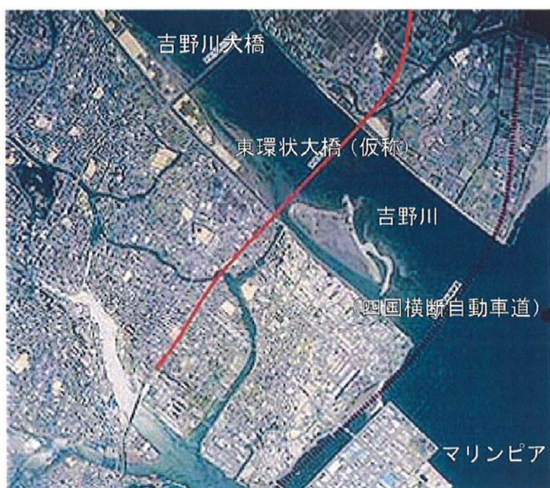
工事実施場所
