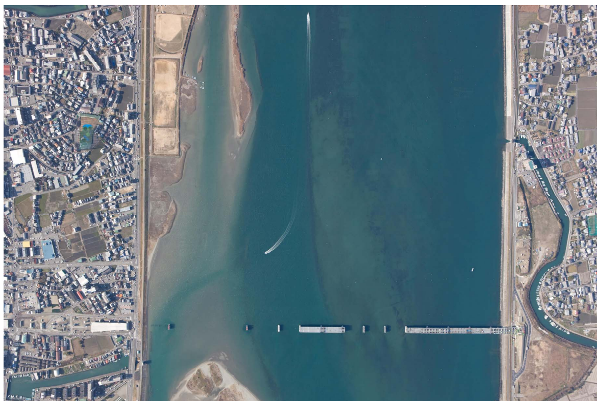
写真 1 工事区域全景 上空より（平成 20 年 1 月）
