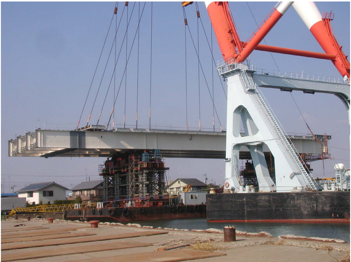
写真7 上部工(一般部):台船積込状況(平成19年12月)
