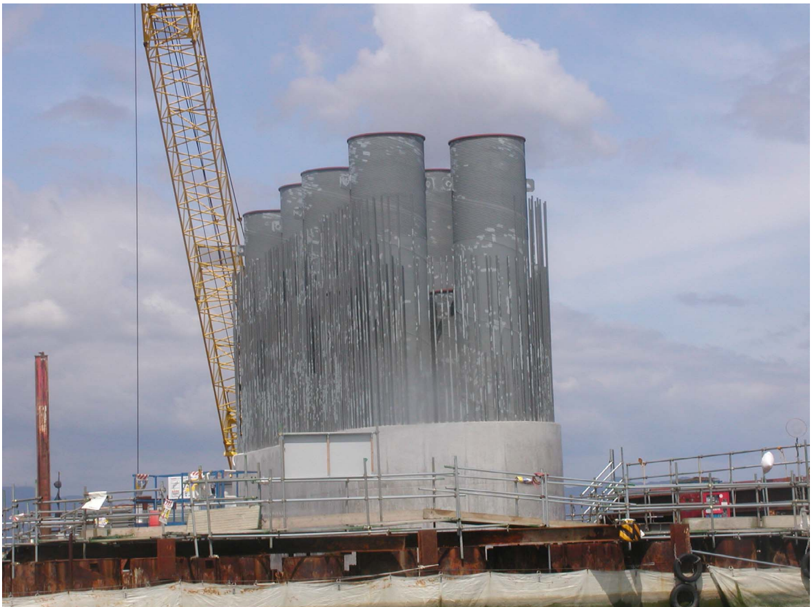
写真3 下部工(干潟部): P2 橋脚完了(平成19年4月)
