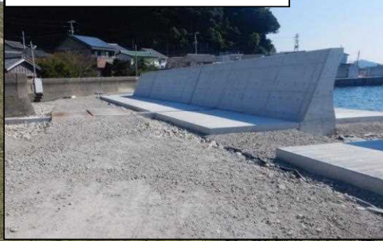
臨港道路 (胸壁) 整備状況
