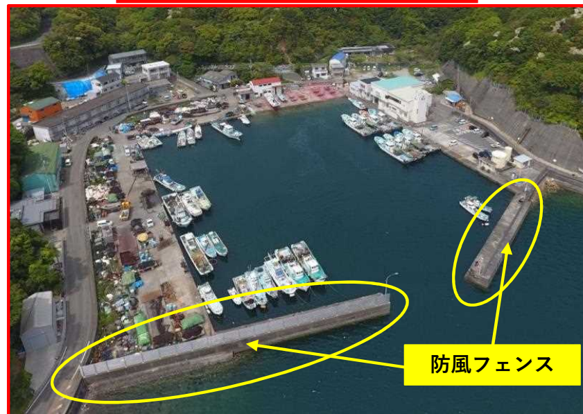
整備後 (防風フェンス)
