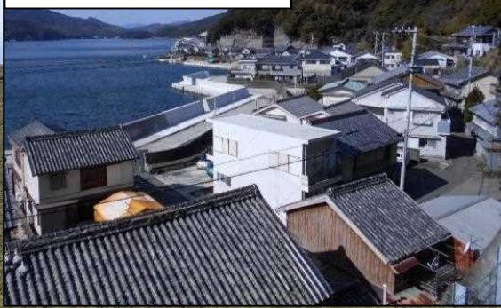
臨港道路整備状況
