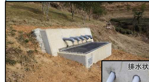
施工後(排水ボーリング)
