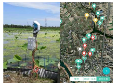
写真2 水位センサーの設置状況(左)と水位監視の表示例(右)
