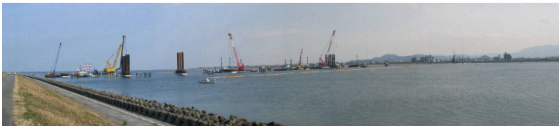
写真 10 左岸堤防上流側 施工状況(鋼管矢板打設・継手処理)(平成16年3月)
