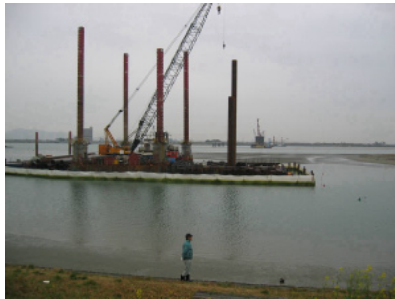
写真 9 右岸側 鋼管矢板打設状況(平成16年3月)
