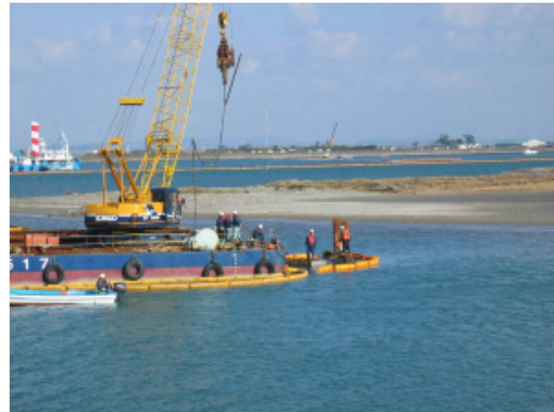
写真 4 右岸側 測量台設置状況(平成15年12月)
