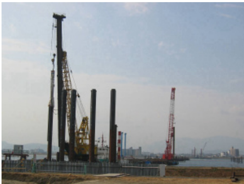
写真 8 左岸側 鋼管矢板打設状況(平成16年2月)
