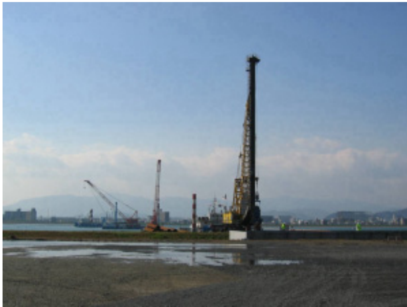
写真 3 左岸側 鋼管矢板打設状況(平成15年12月)
