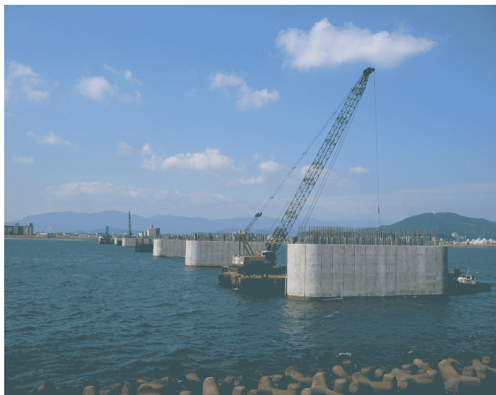
写真 11 河川内の橋脚(左岸堤防上より平成16年5月)
