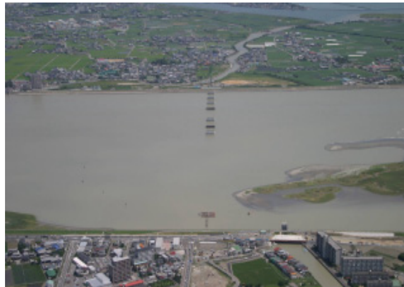
写真 12 河川内の橋脚(右岸上空より平成16年6月)
