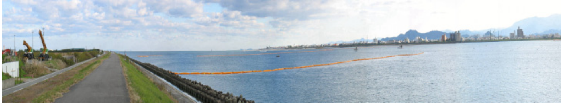
写真 2 左岸側より汚濁拡散防止膜設置(平成15年11月)
