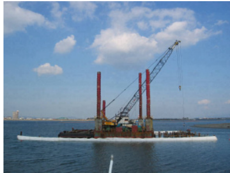
写真 6 右岸側 導杭・導枠設置状況(平成16年1月)
