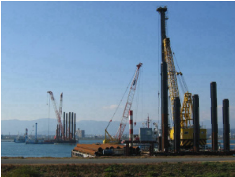
写真 5 左岸側 鋼管矢板打設状況(平成16年1月)
