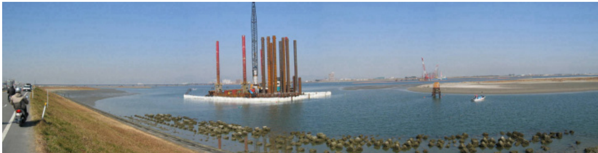
写真 7 右岸側 鋼管矢板打設状況(平成16年2月)
