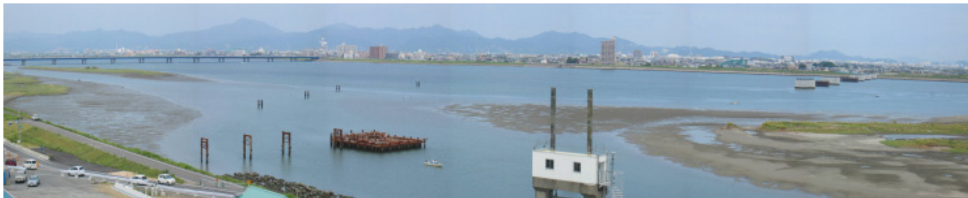
写真 13 工事終了後河川内の状況(右岸堤防上より平成16年8月)
