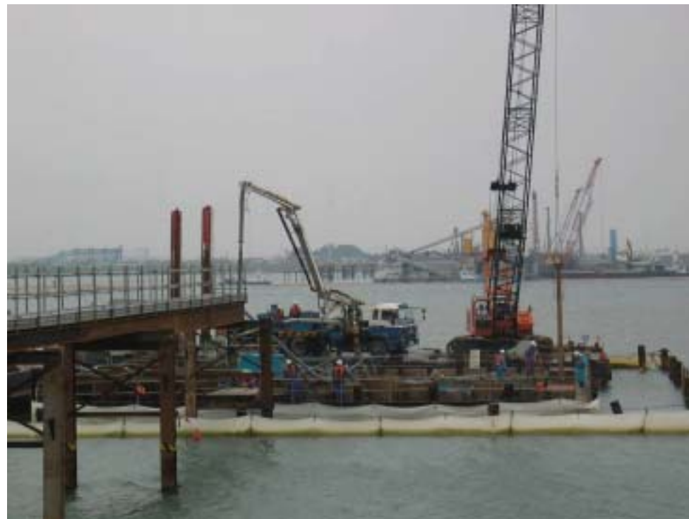
写真 4 左岸コンクリート打設状況 (平成16年5月)
