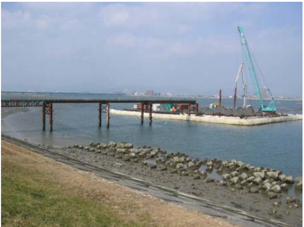
写真 13 右岸干潟部工事区域全景（平成17年2月）
