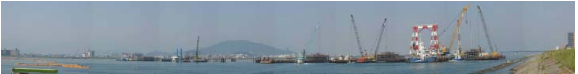
写真 3 左岸下流側より一般部工事区域全景 (平成16年5月)
