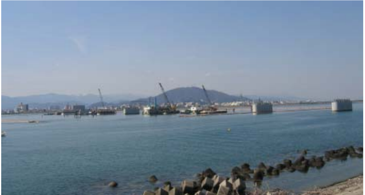
写真 12 左岸下流側より一般部工事区域全景（平成17年2月）
