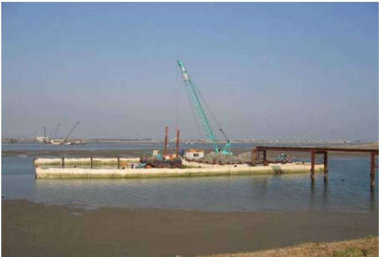
写真 15 右岸干潟部工事区域全景（平成17年3月）
