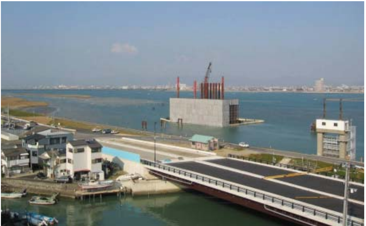
写真 9 右岸干潟部工事区域全景 (平成16年12月)
