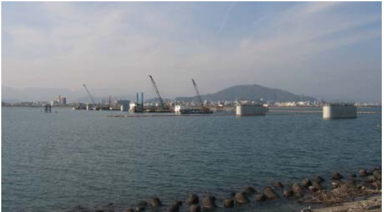
写真 10 左岸下流側より一般部工事区域全景 (平成17年1月)
