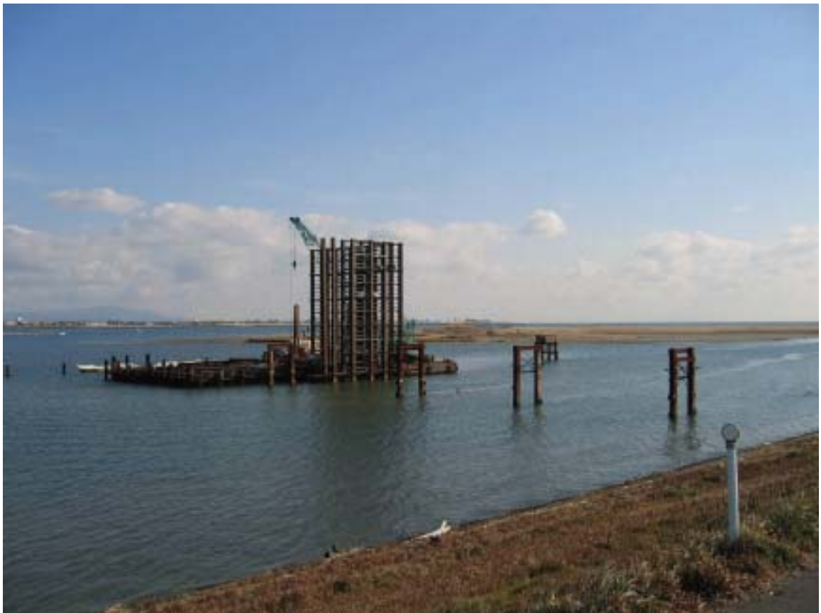
写真 11 右岸干潟部工事区域全景 (平成17年1月)
