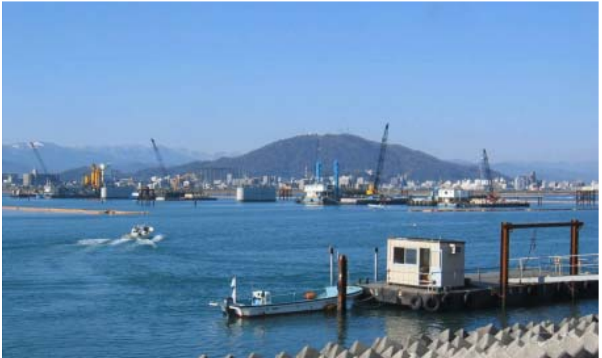
写真 14 左岸下流側より一般部工事区域全景（平成17年3月）
