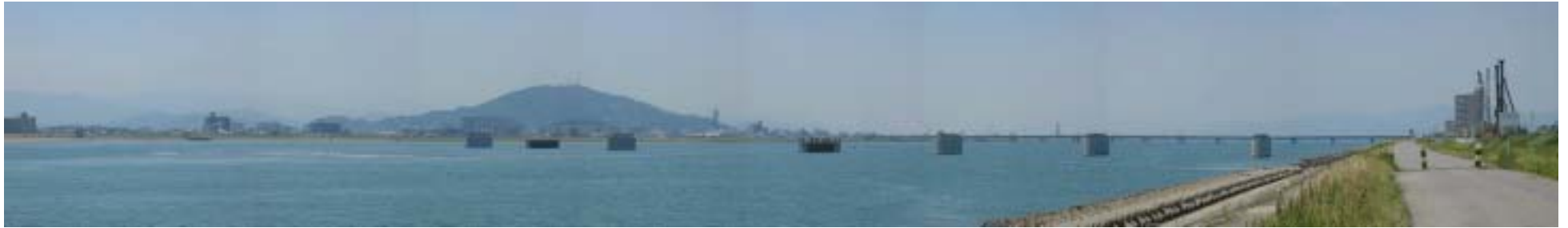
写真 5 左岸下流側より一般部工事区域全景（平成16年6月）
