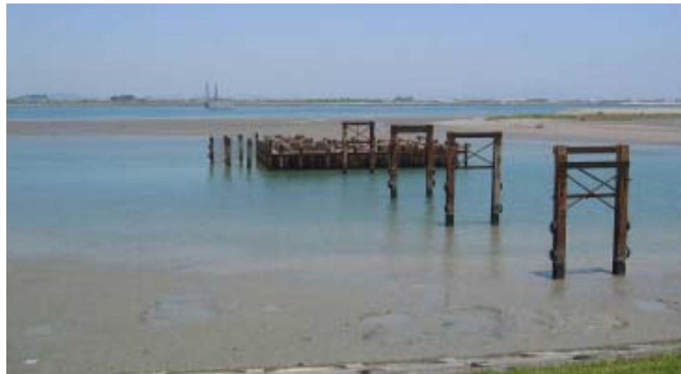
写真 6 右岸干潟部工事区域全景（平成16年6月）
