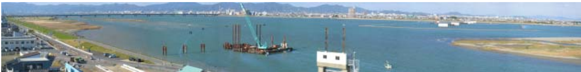
写真 7 右岸干潟部工事区域全景(平成16年11月)
