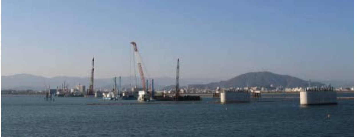
写真 8 左岸下流側より一般部工事区域全景 (平成16年12月)
