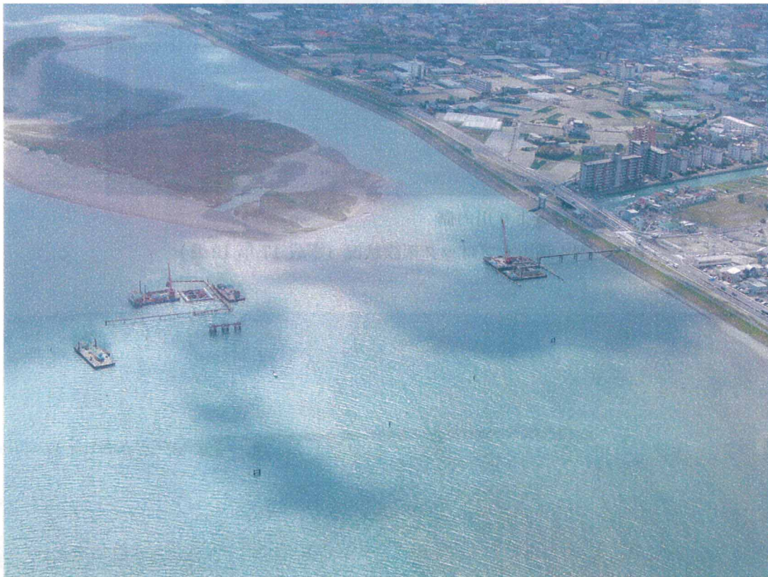
写真 12 右岸側工事区域～河口干潟 上空より（平成18年4月）
