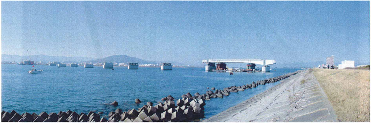
写真8 左岸（川内）下流側より一般部工事区域全景（平成17年12月）
