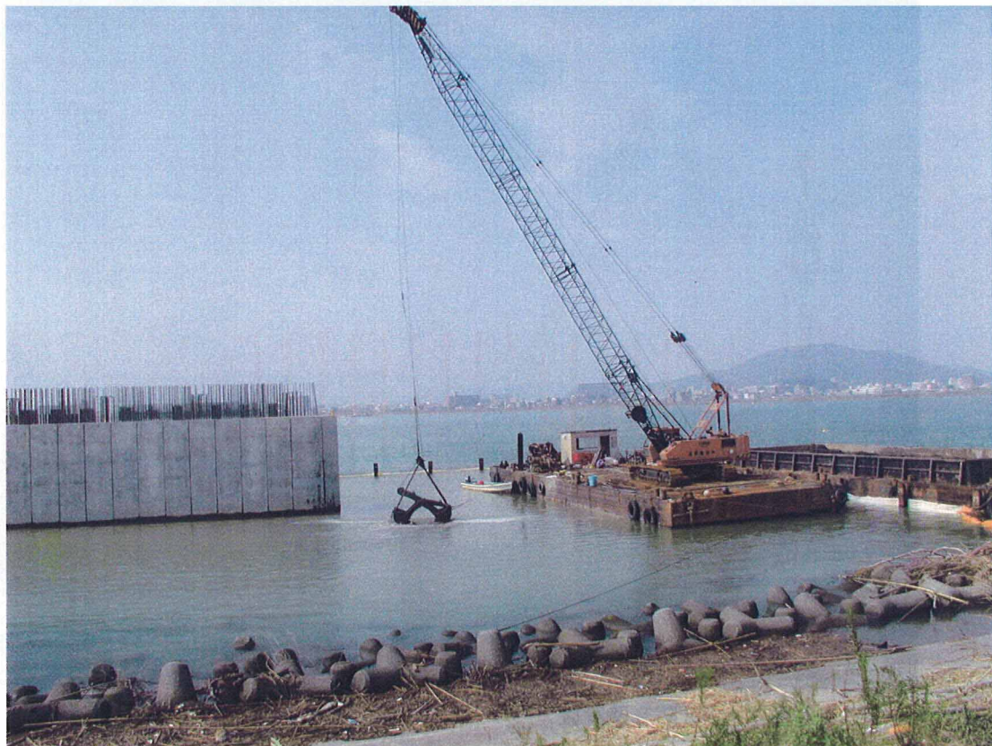
写真5 P14部 埋戻状況（平成17年9月）
