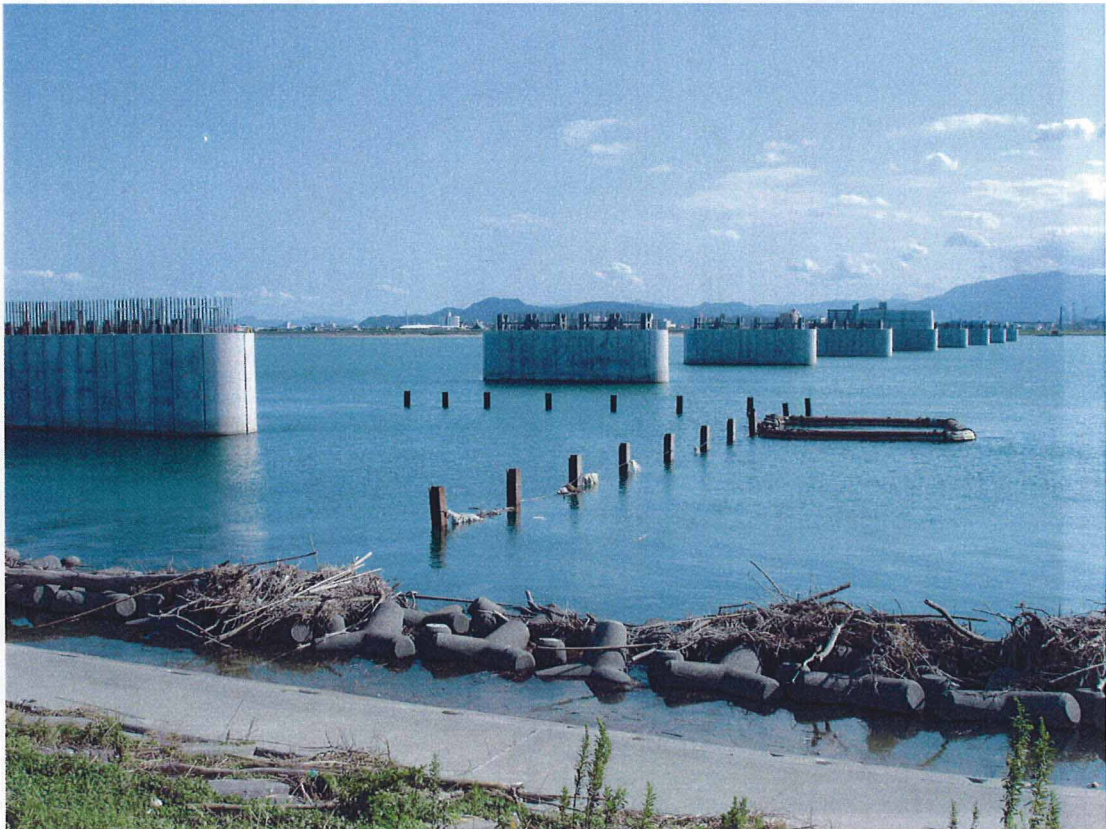
写真4 左岸（川内）側より一般部工事区域の状況（平成17年9月）
