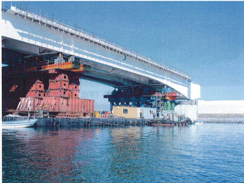
写真9 P13橋脚付近より川内側 P13～P14鋼桁大ブロック架設状況（平成17年12月）
