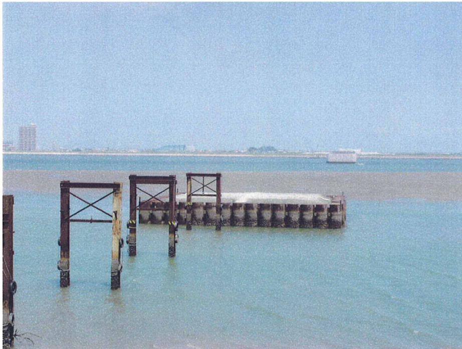
写真3 右岸(住吉)干潟部工事区域全景(平成17年8月)
