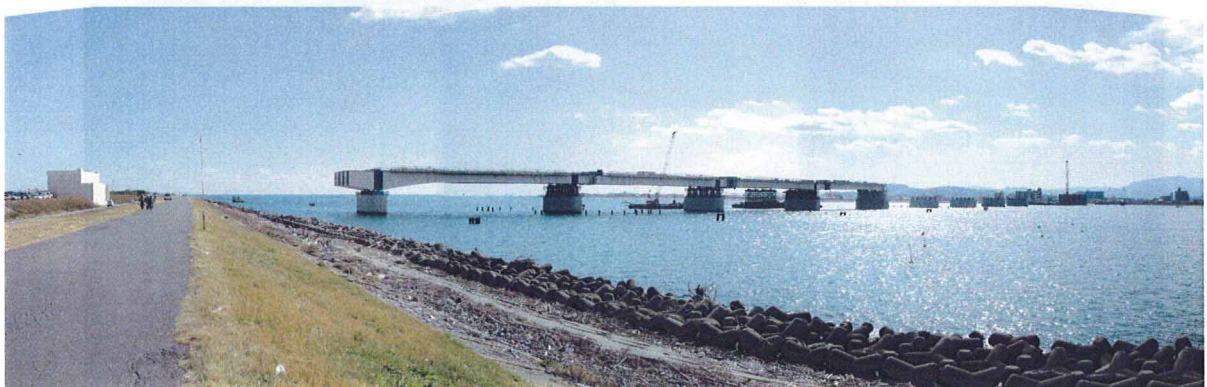
写真10 上部工P10～A2架設後全景（平成18年1月）
