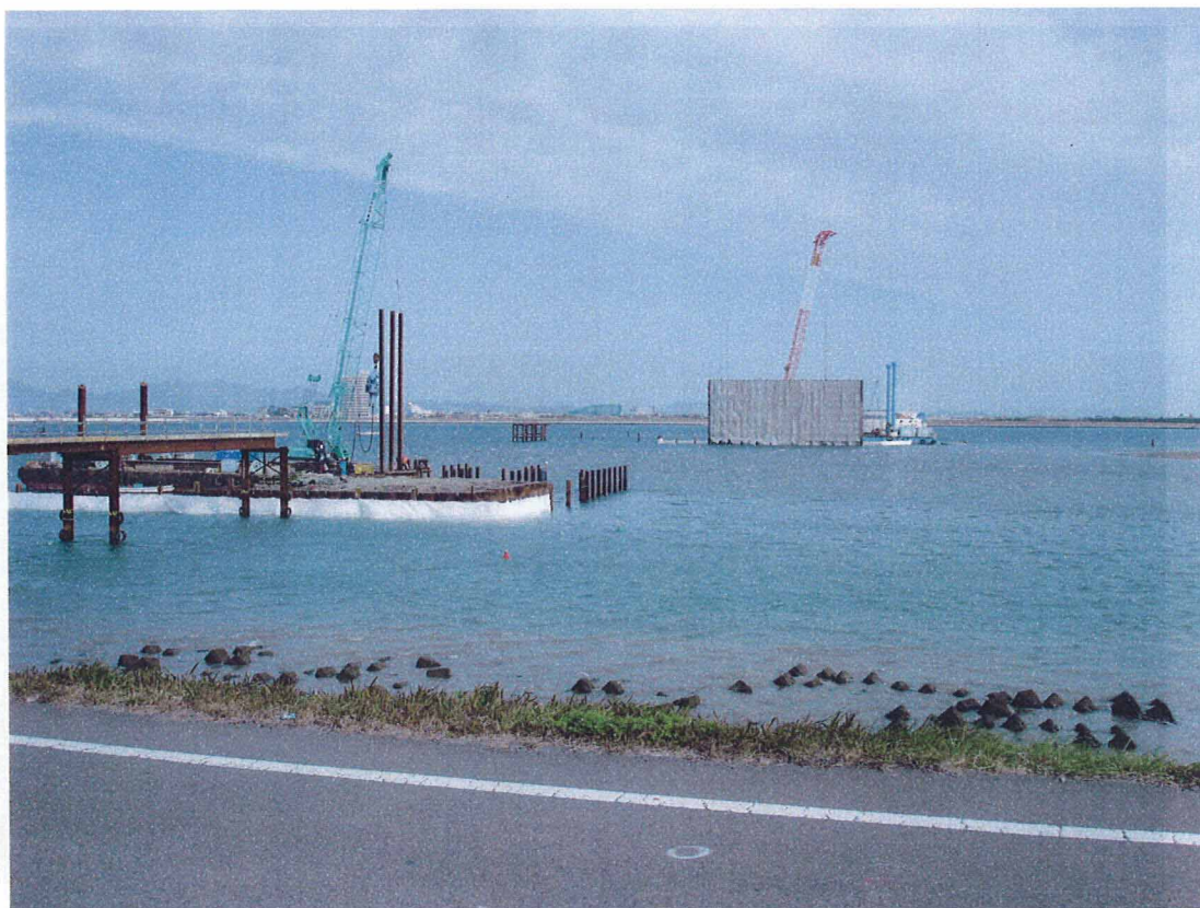
写真6 右岸（住吉）干潟部 工事区域全景（平成17年11月）
