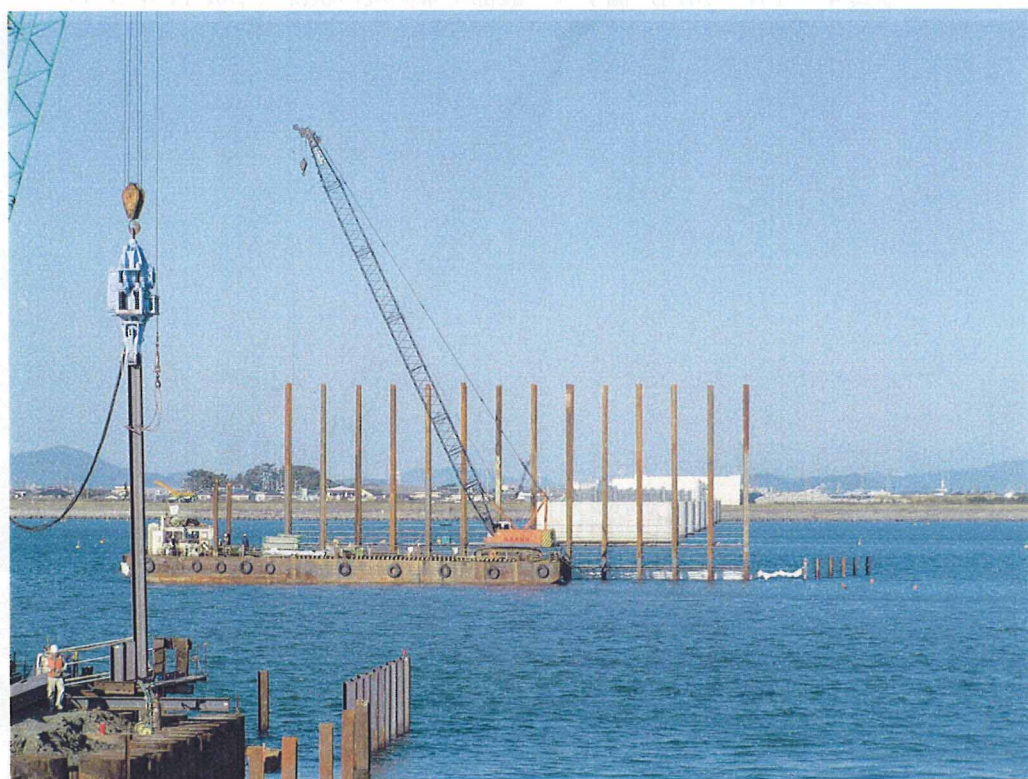
写真7 P3防音壁設置 P2構台H網杭打設（平成17年11月）
