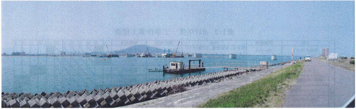
写真1 左岸(川内)下流側より一般部工事区域全景(平成17年4月)
