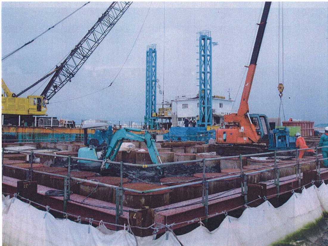
写真 11 P2部工事状況（平成18年3月）
