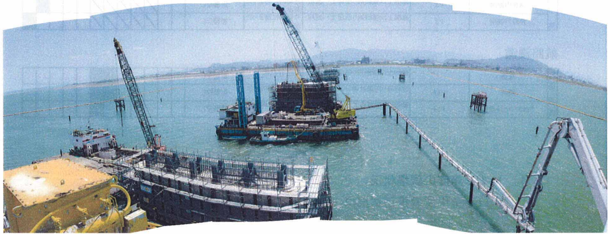
写真2 P11橋脚付近より住吉側 P10橋脚(中央)躯体コンクリート打設状況(平成17年4月)
