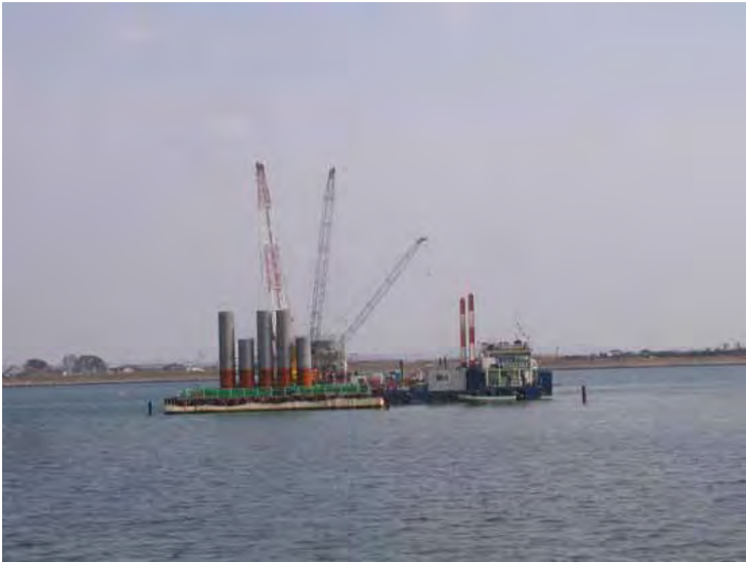
写真9 干潟部(P3) 鋼管据付状況(平成19年3月)
