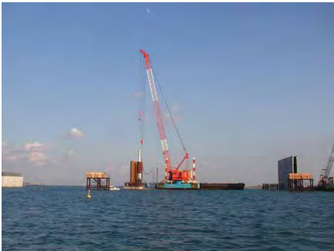
写真6 干潟部(P5) 鋼管矢板打設状況(平成18年11月)
