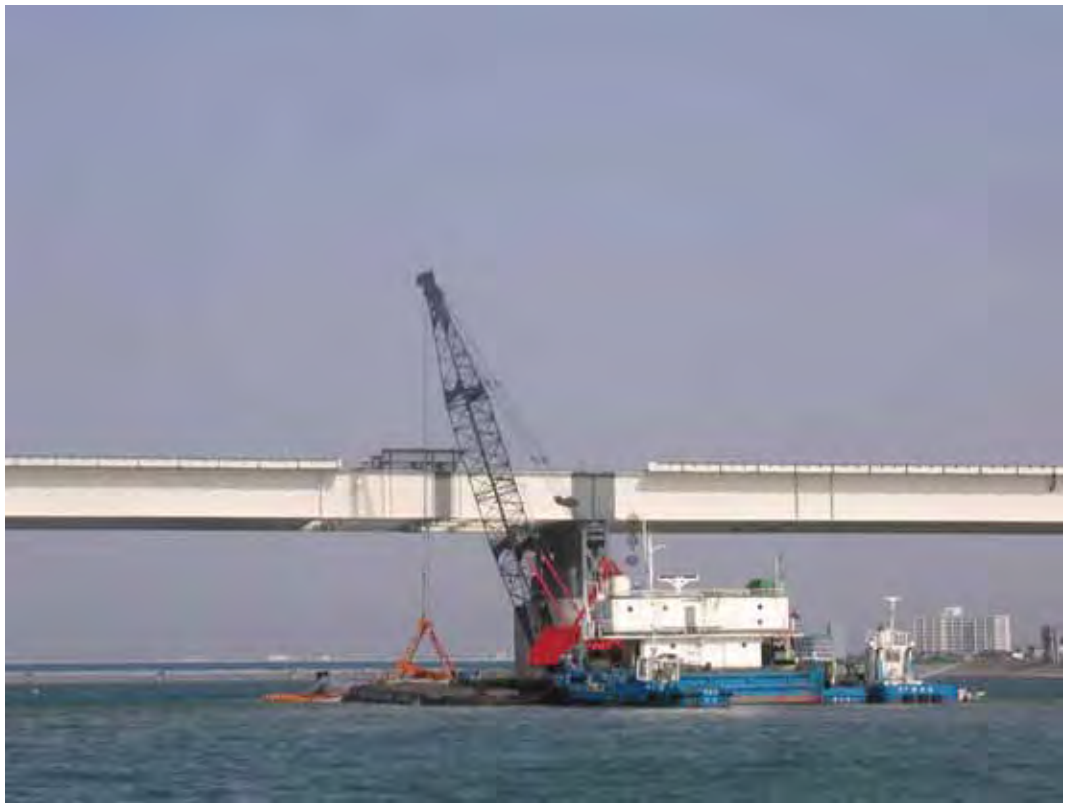
写真5 一般部橋脚廻り埋戻状況(平成18年4月)
