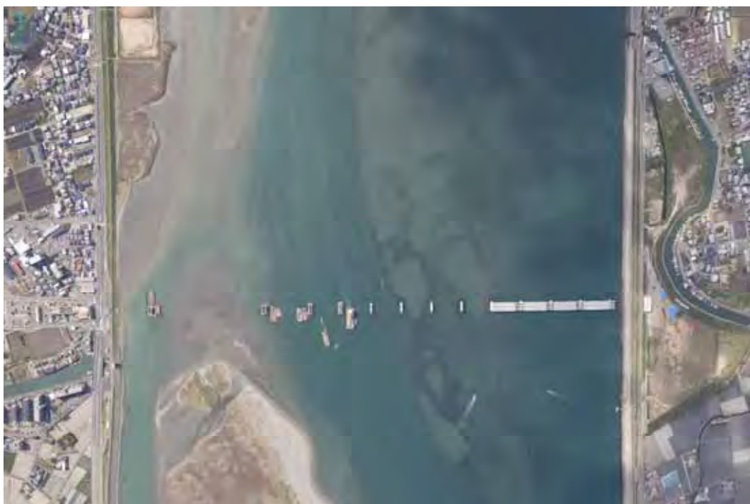
写真12 工事区域全景 上空より(平成19年4月)
