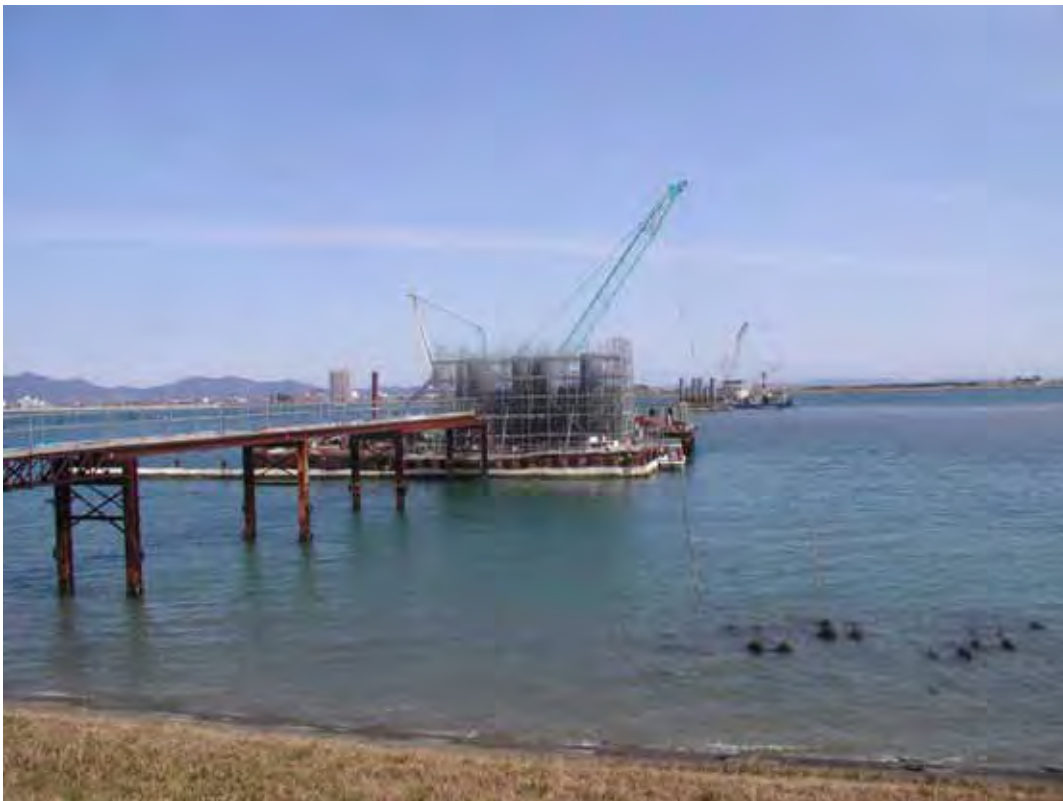
写真10 右岸側(住吉) 工事区域全景(平成19年3月)
