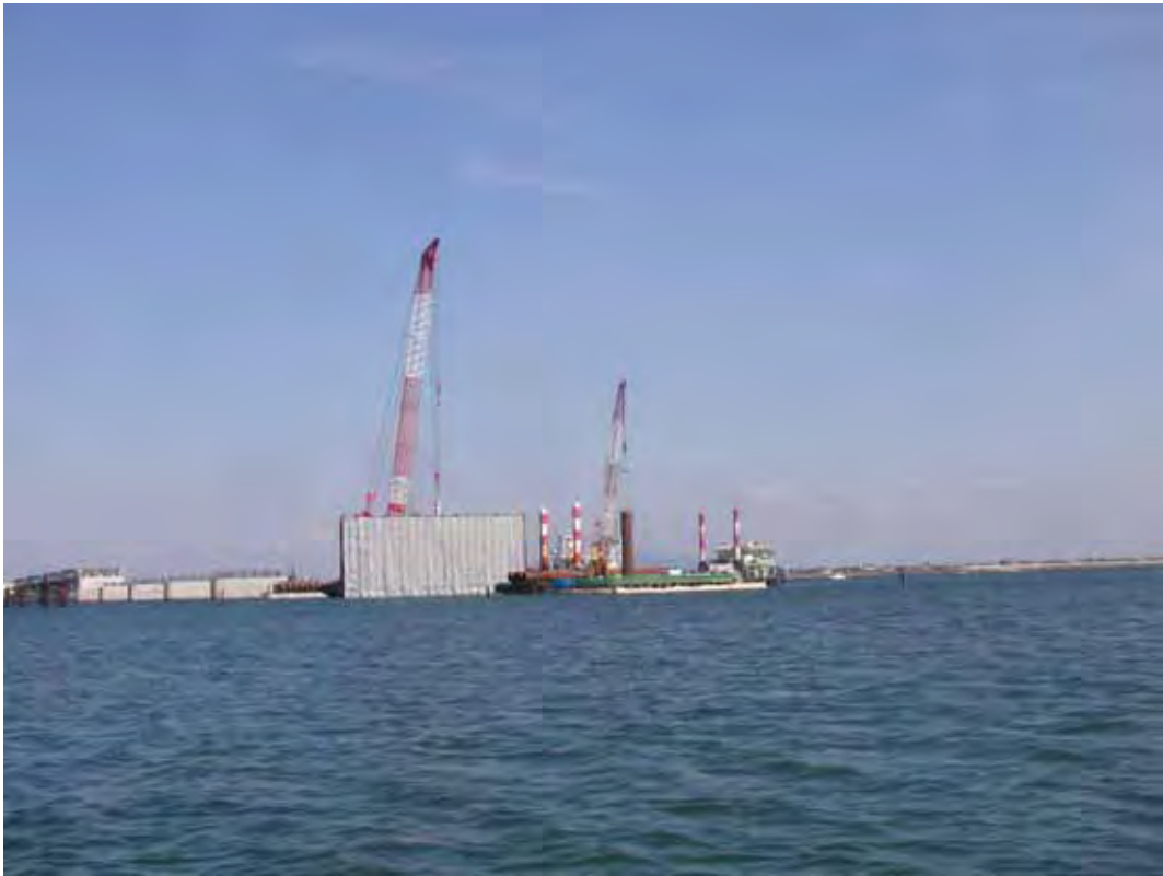
写真7 干潟部 鋼管矢板打設及び鋼管建込み状況 (平成19年1月)
