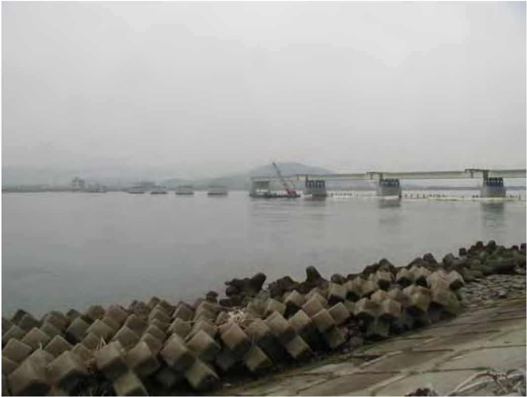
写真1 左岸(川内) 下流側より一般部工事区域全景(平成18年4月)
