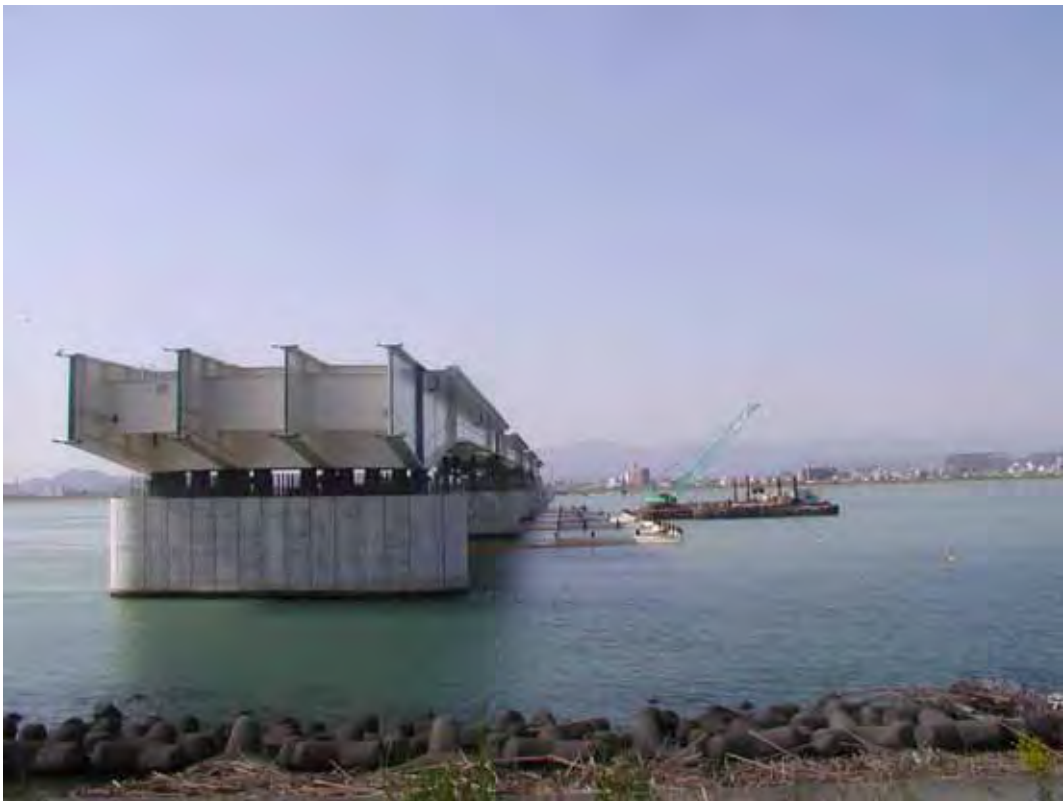
写真4 一般部 橋脚廻り埋戻状況(平成18年4月)
