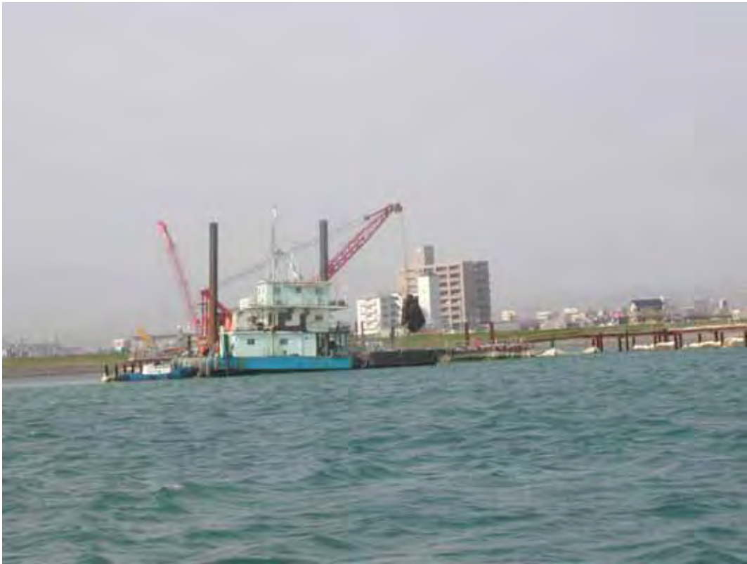
写真3 干潟部(P3) 井筒内掘削状況(平成18年4月)
