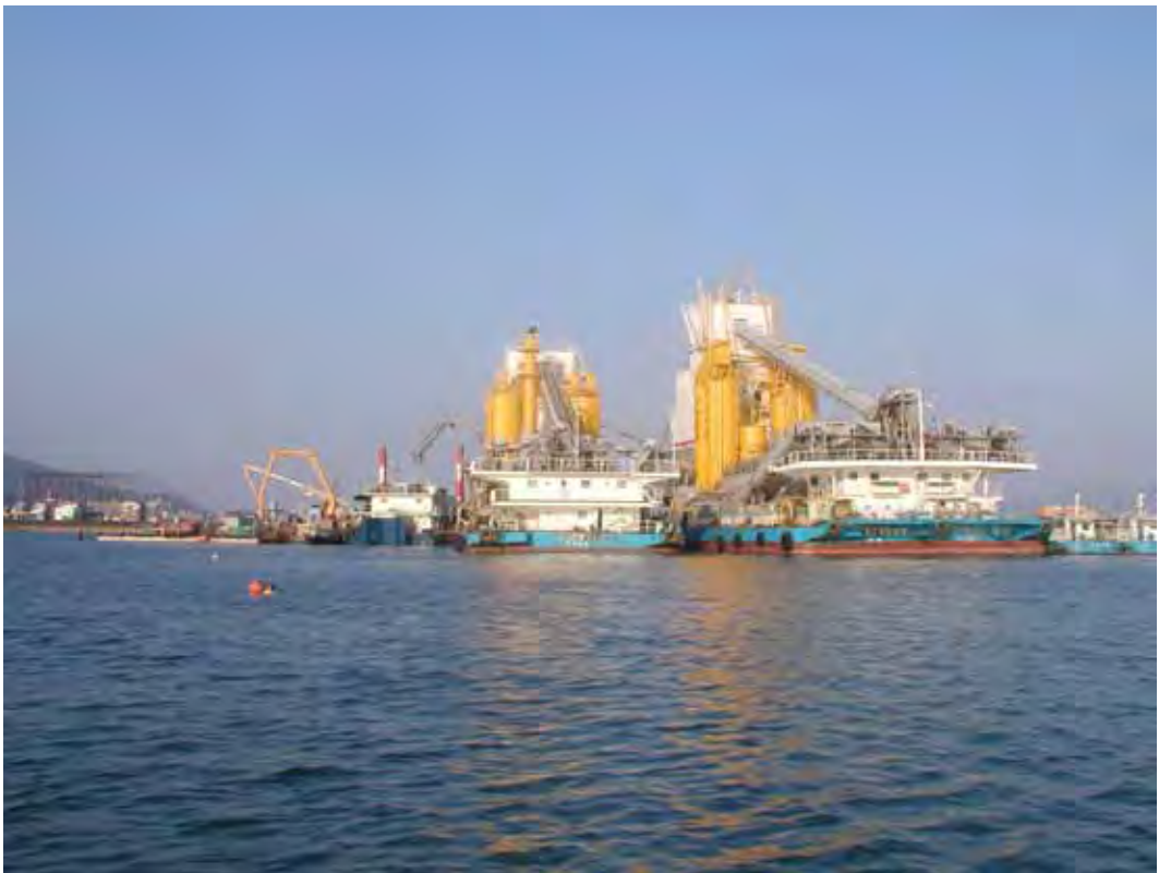
写真8 干潟部(P3) コンクリート打設状況(平成19年2月)
