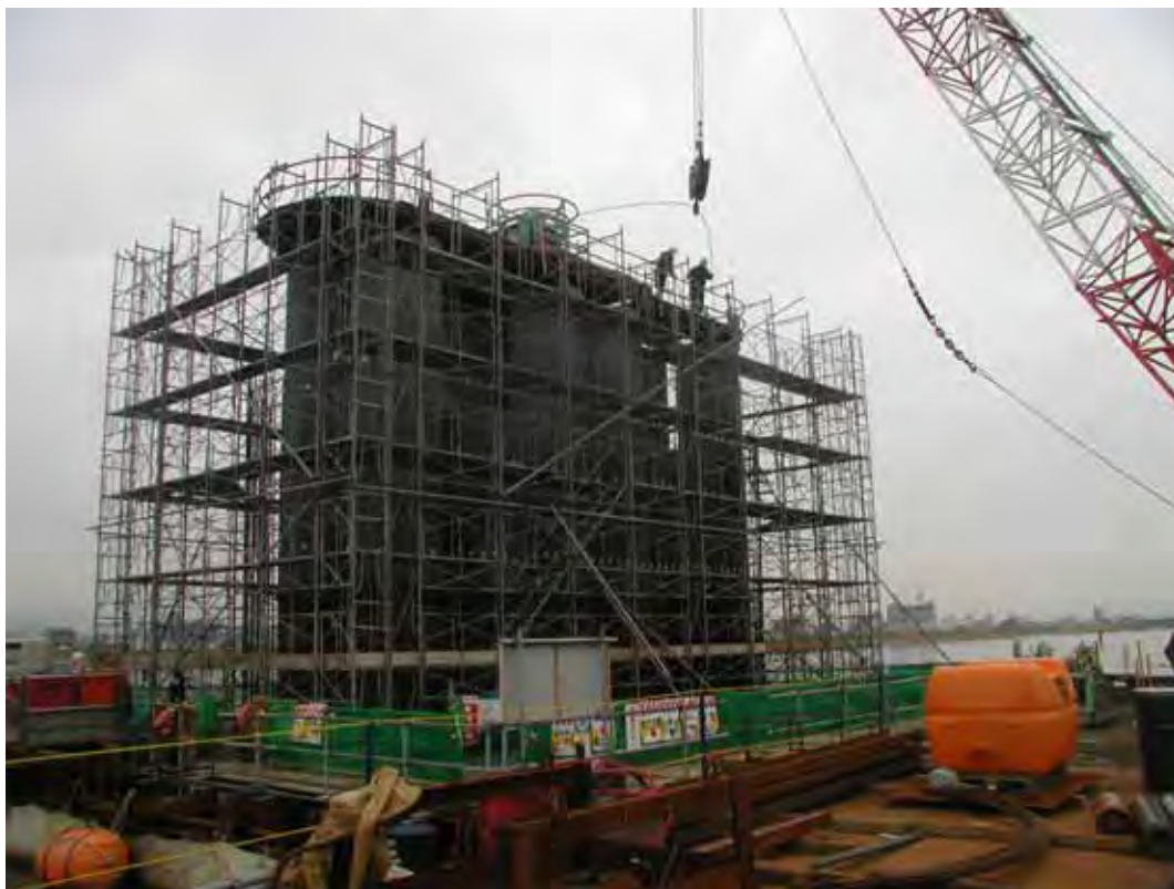
写真11 干潟部(P3) PCストランド施工状況 (平成19年3月)
